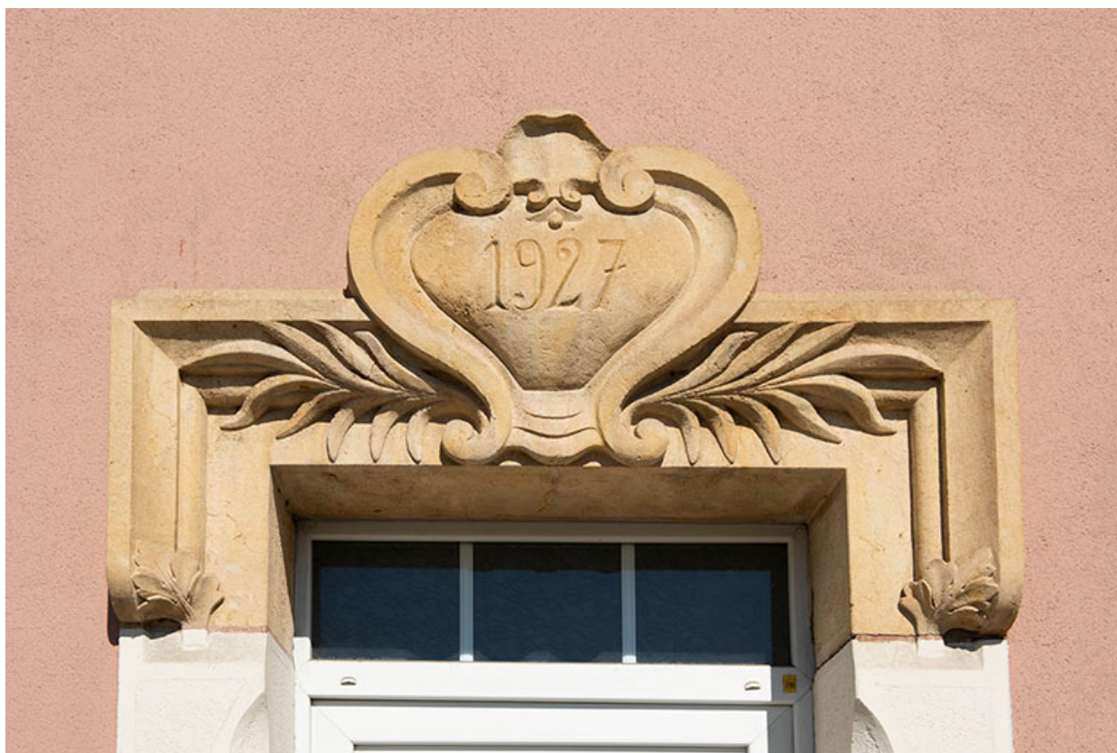
Façade antérieure : linteau daté 1927.
