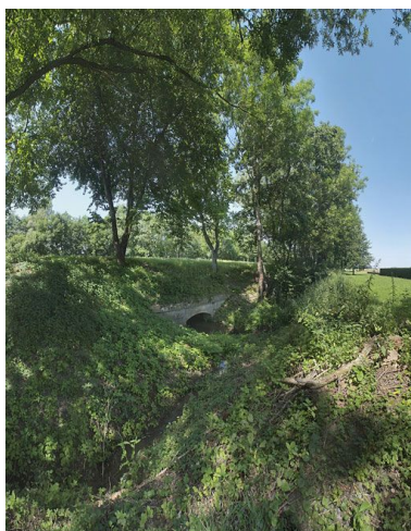
Vue de l'aqueduc. Phot. Thierry Kuntz IVR26_20112103267NUC4A
