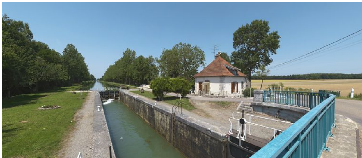
Vue d'ensemble du site prise d'aval.
