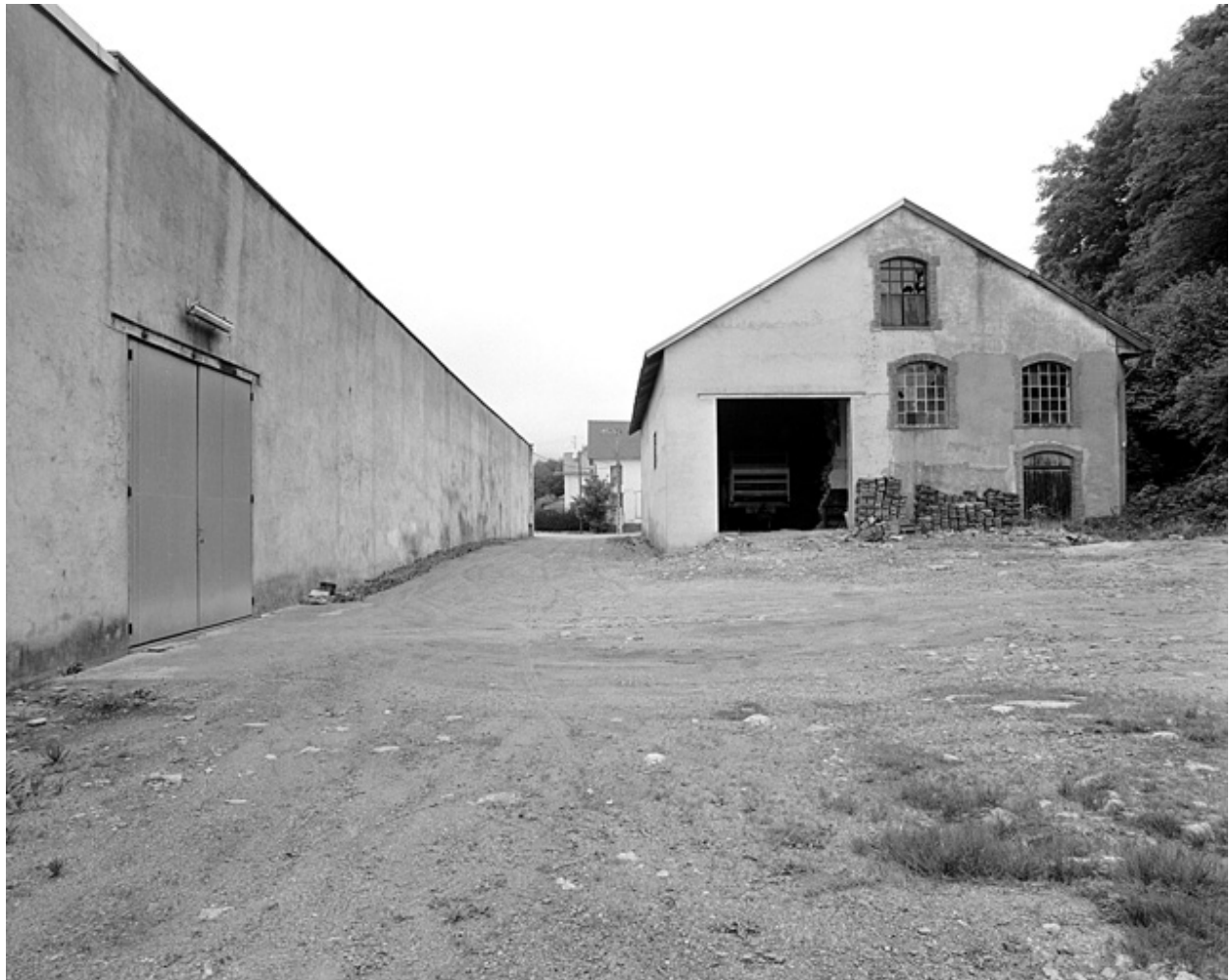
Façade postérieure de la salle des machines.
