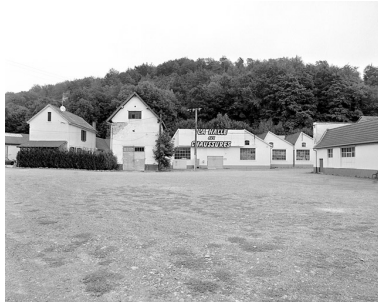
Conciergerie, logement et atelier de réparation. Phot. Yves Sancey IVR43_19999000312X
