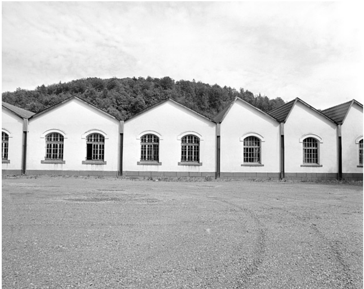
Murs-pignons de l'atelier de fabrication.
