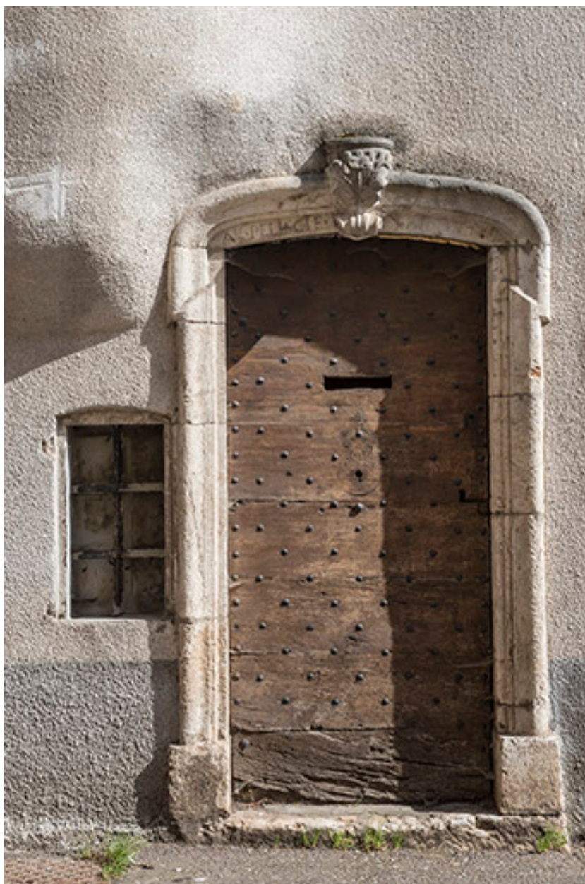
Porte avec linteau en arc surabaissé.
