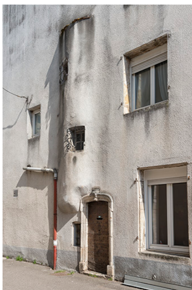
Maison à tour, rue Jean Bogé. Phot. Jérôme Mongreville IVR43_20177000509NUC4A
