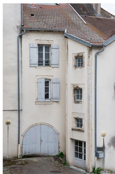
Détail d'une travée. Phot. Jérôme Mongreville IVR43_20177000725NUC4A
