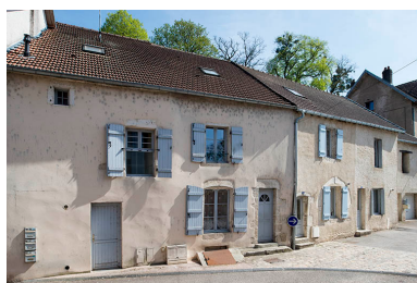
Maisons rue Jean Bogé. Phot. Jérôme Mongreville IVR43_20177000503NUC4A
