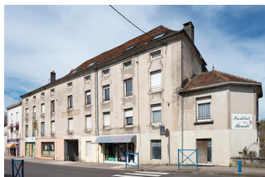
Ancienne gendarmerie, située rue François Mitterrand. Phot. Jérôme Mongreville IVR43_20187000219NUC4A
