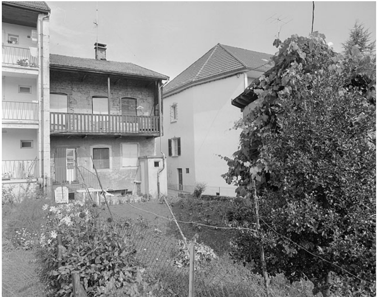
Façade postérieure avec balcon en galerie.
