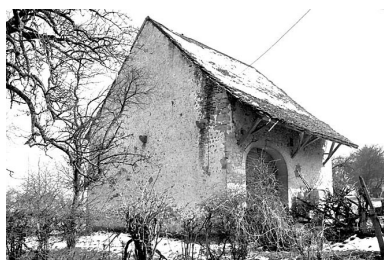
Vue de trois quarts gauche. Phot. Bernard Lardière IVR43_19829000247Z
