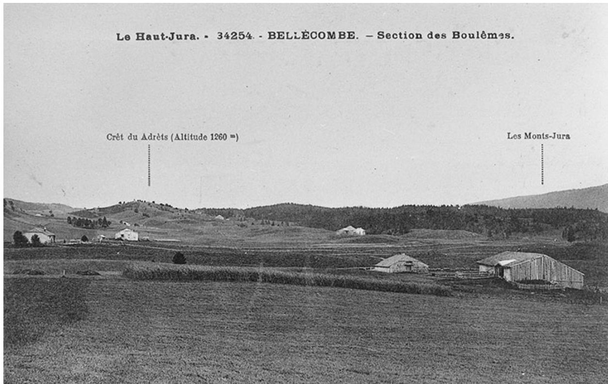
Vue générale de la section des Boulèmes.
