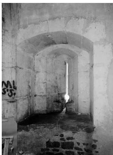
Tour Blondeau, casemate inférieure, détail : archère-canonnaire (vue intérieure). Phot. Michel Rosso IVR26_19882102287V
