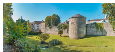
Vue générale. Phot. Thierry Kuntz IVR26_20232100364NUC4A
