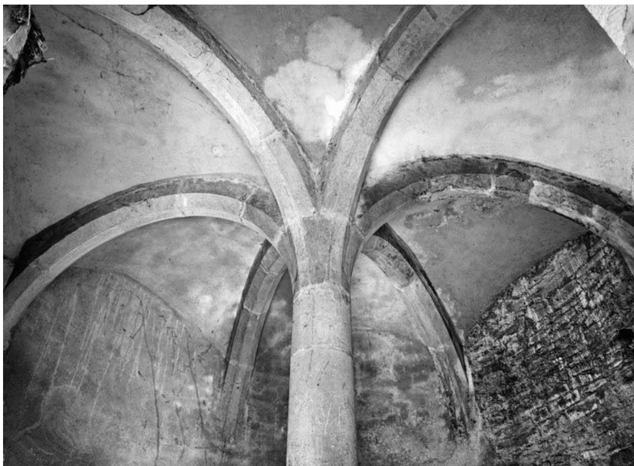
Tour Blondeau, casemate inférieure, détail : voûtement.
