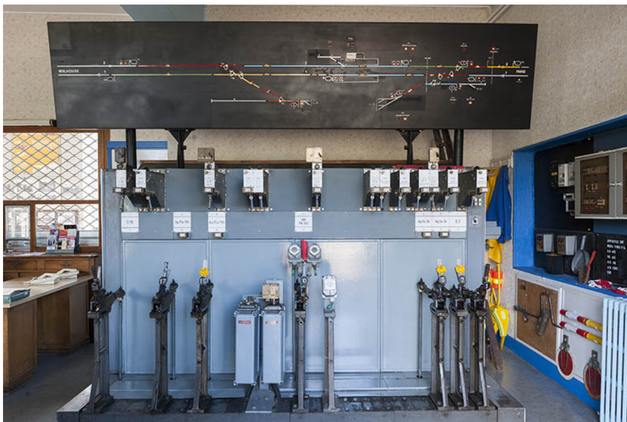
Gare de Port-d'Atelier : intérieur du poste d'aiguillage.
