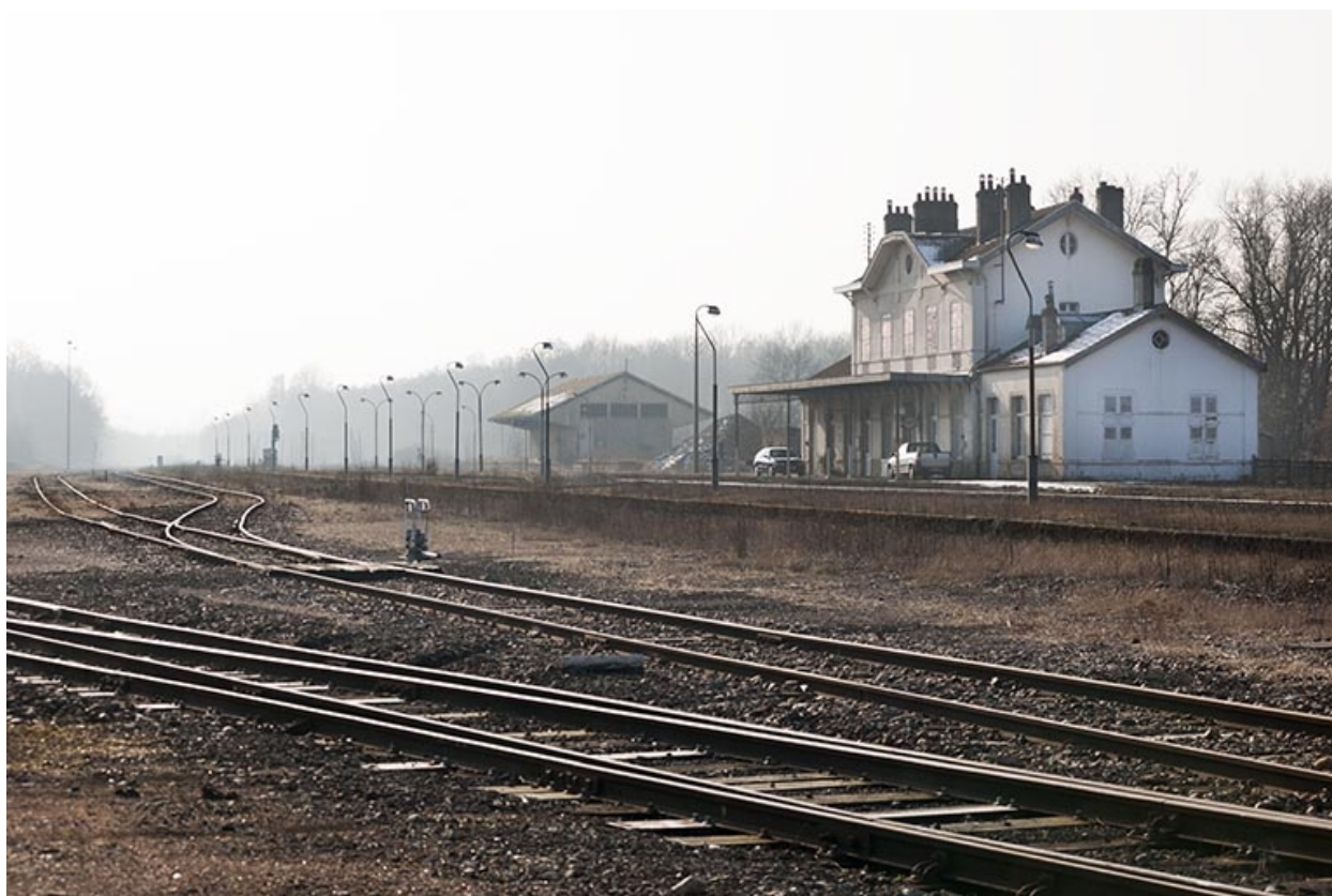
Gare de Port-d'Atelier : vue d'ensemble de la gare de voyageurs et de celle de marchandises.
