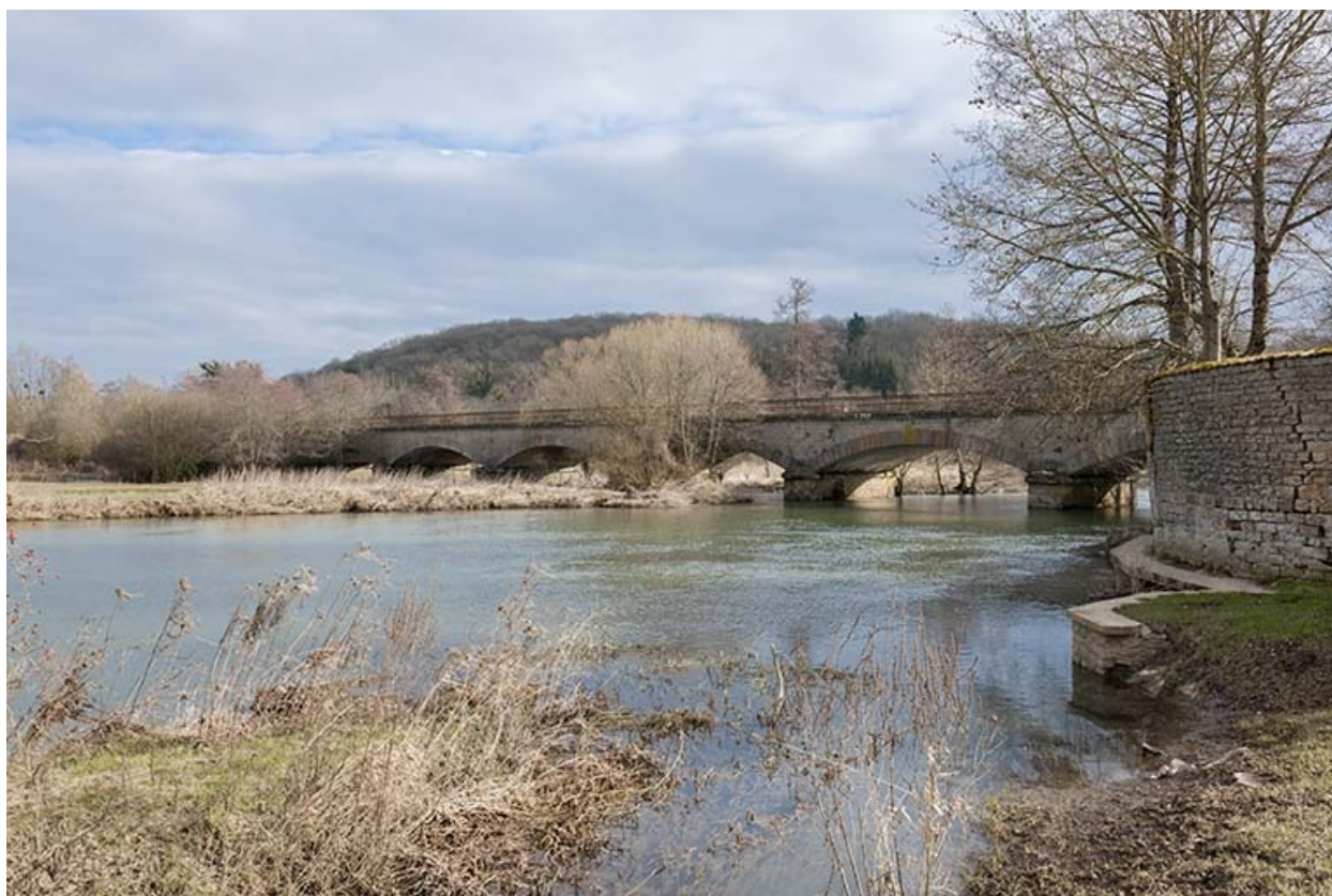
Pont ferroviaire sur la Lanterne (ligne Nancy-Gray).
