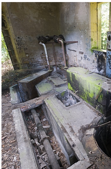
Station de pompage : détail de l'intérieur. Phot. Marc Loukachine IVR43_20127000143NUC4A
