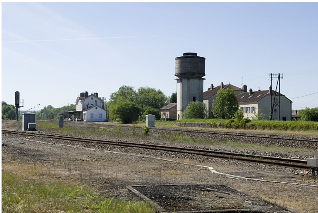
Gare de Port-d'Atelier : vue d'ensemble du site depuis le nord.
