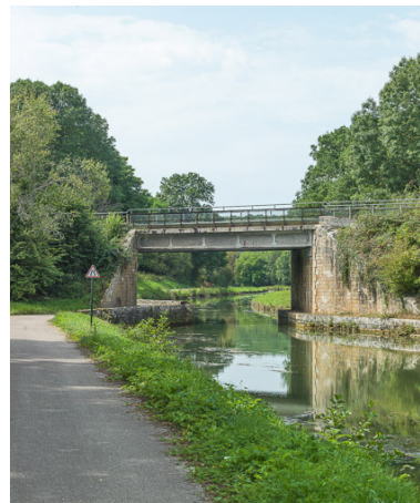
Vue d'ensemble du pont.
