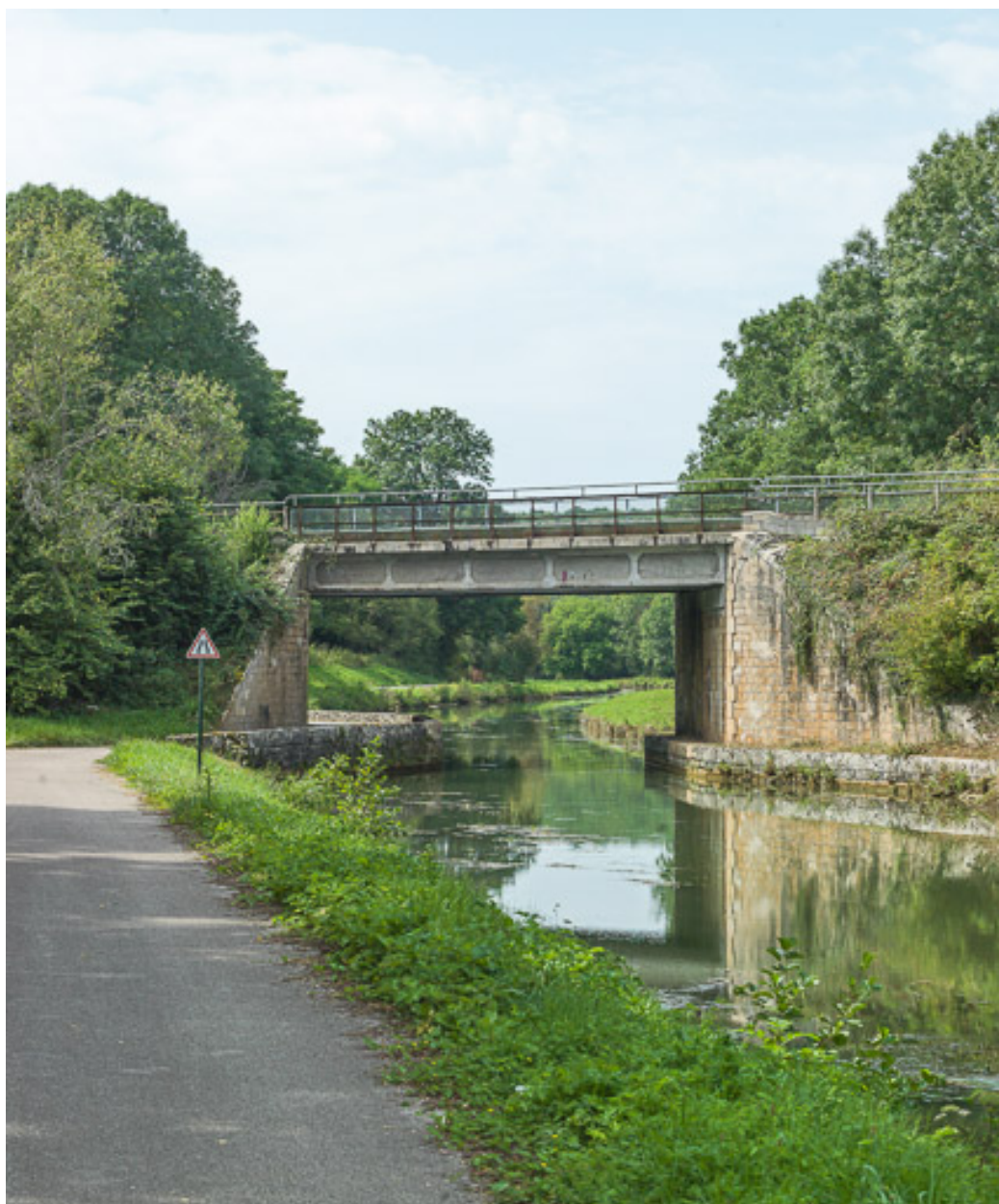
Vue d'ensemble du pont.
