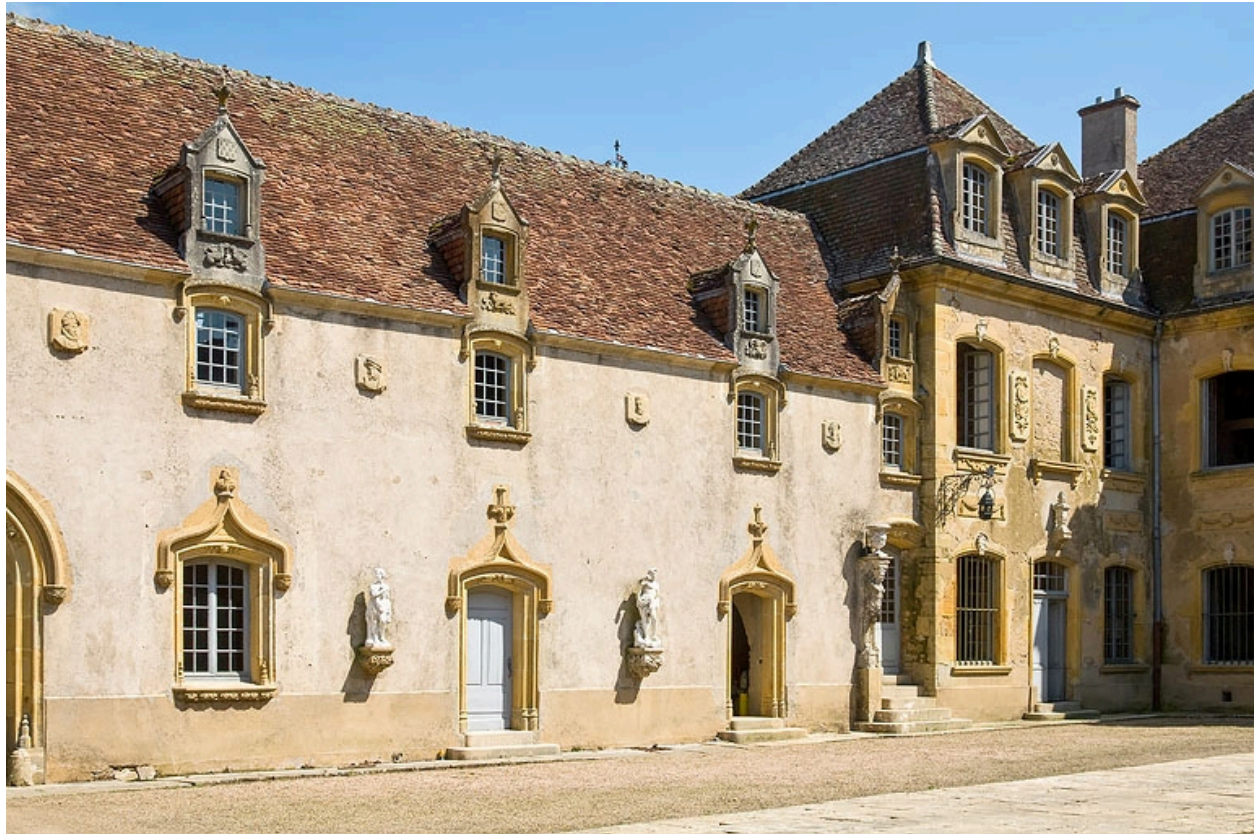
Vue du pavillon d'angle et de l'aile, à l'est de la cour d'honneur.
