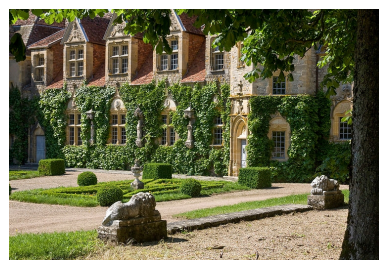
Vue de la façade sud de l'ail abritant la grande salle (ancienne grange), transformée au début du XXe siècle par l'ajout de lucarnes et d'une tour d'escalier hors-oeuvre provenant de l'ancien château de Moulin-l'Arconce (commune de Poisson). Phot. Jean-Pierre Gobillot IVR26_20207100103NUC2A
