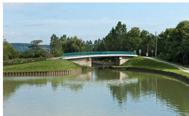
Vue du pont. Phot. Pierre-Marie Barbe-Richaud IVR26_20112103934NUC4AQ
