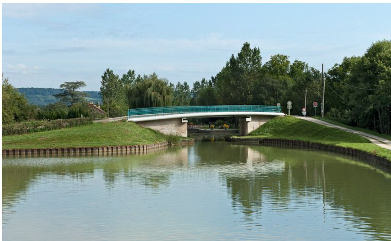
Vue du pont.
