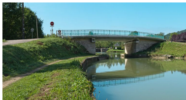
Vue du pont. Phot. Pierre-Marie Barbe-Richaud IVR26_20112103941NUC4AQ
