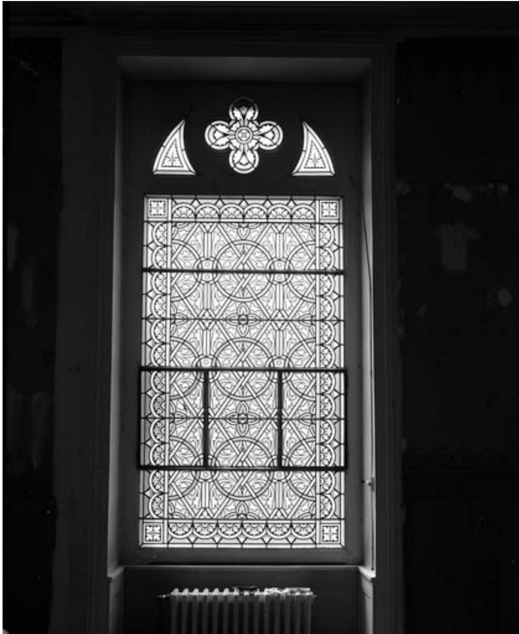
Mur sud : vitrail géométrique (baie 4).
