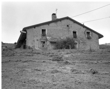
Face droite avec four en appentis. Phot. Jérôme Mongreville IVR43_19943900708X
