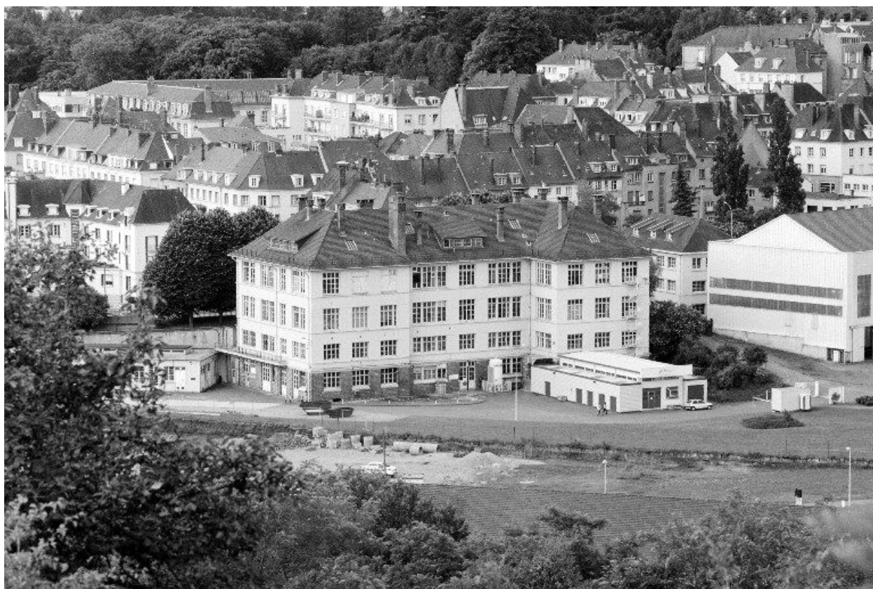
Le laboratoire vu depuis la Montagne des Boulets (nord-est).
