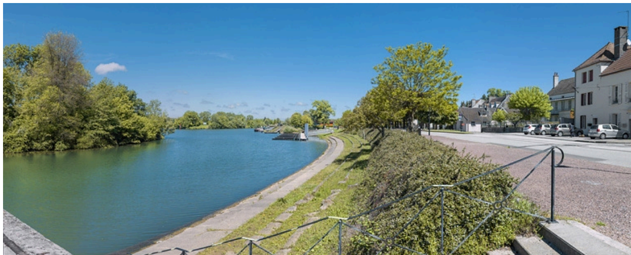
Vue d'ensemble des quais à gradins, avant leur restauration.
