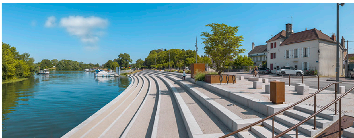
Vue d'ensemble des quais après leur réaménagement.
