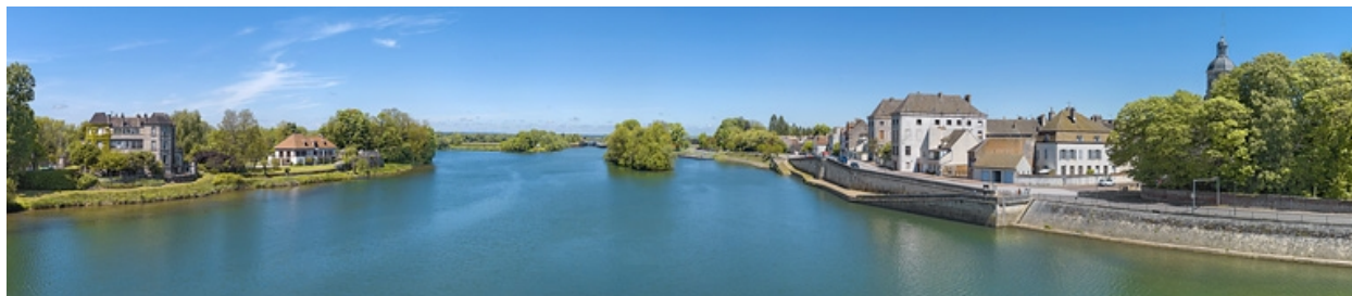
Vue d'ensemble des quais, rive gauche, en amont du pont routier.
