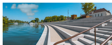
Vue d'ensemble des quais après leur réaménagement. Phot. Thierry Kuntz IVR26_20192100146NUC4A
