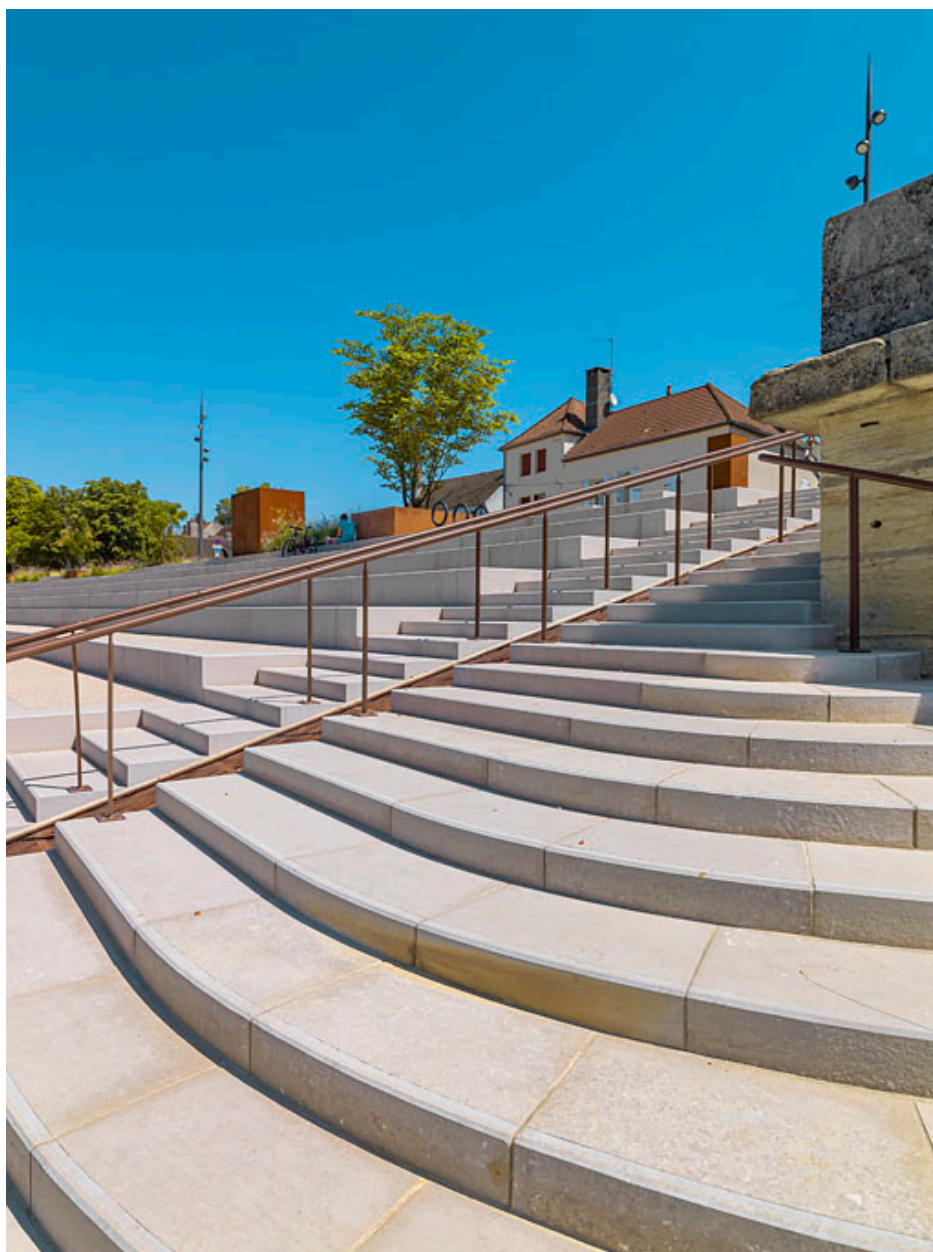
Détail des gradins des quais après leur réaménagement.
