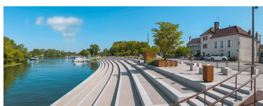
Vue d'ensemble des quais après leur réaménagement. Phot. Thierry Kuntz IVR26_20192100147NUC4A
