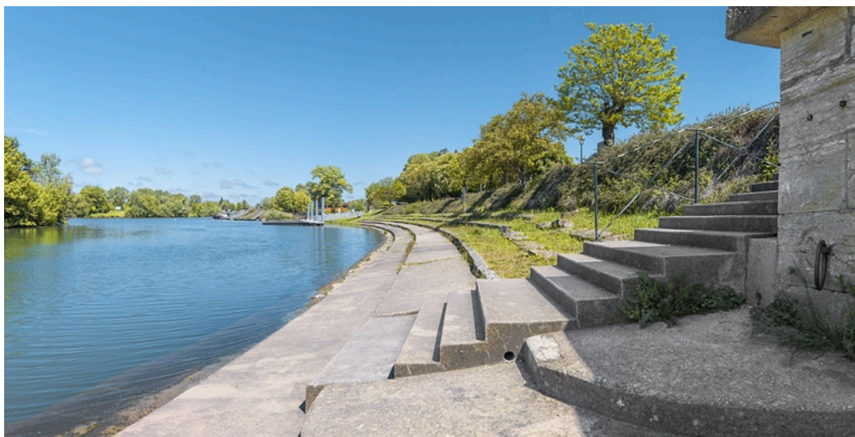
Vue rapprochée des quais à gradins avant leur restauration.
