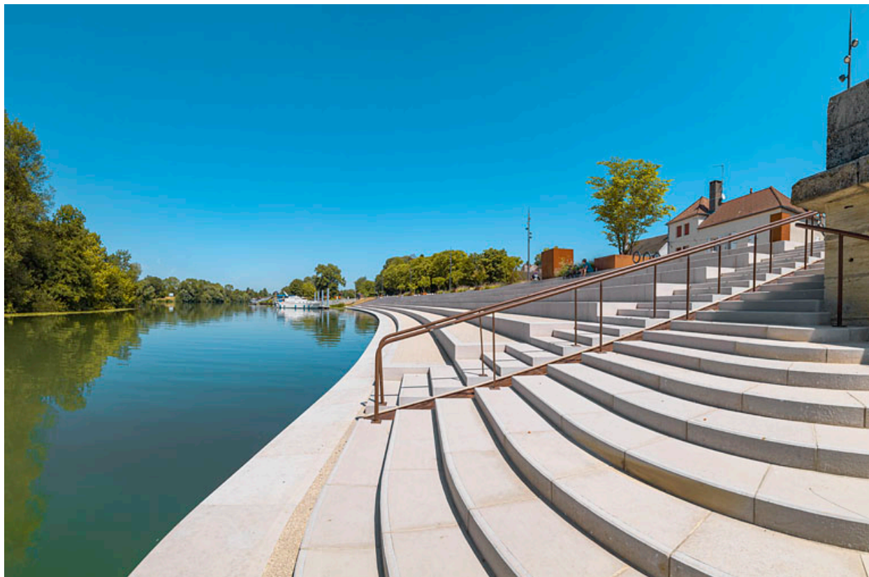
Vue d'ensemble des quais après leur réaménagement.
