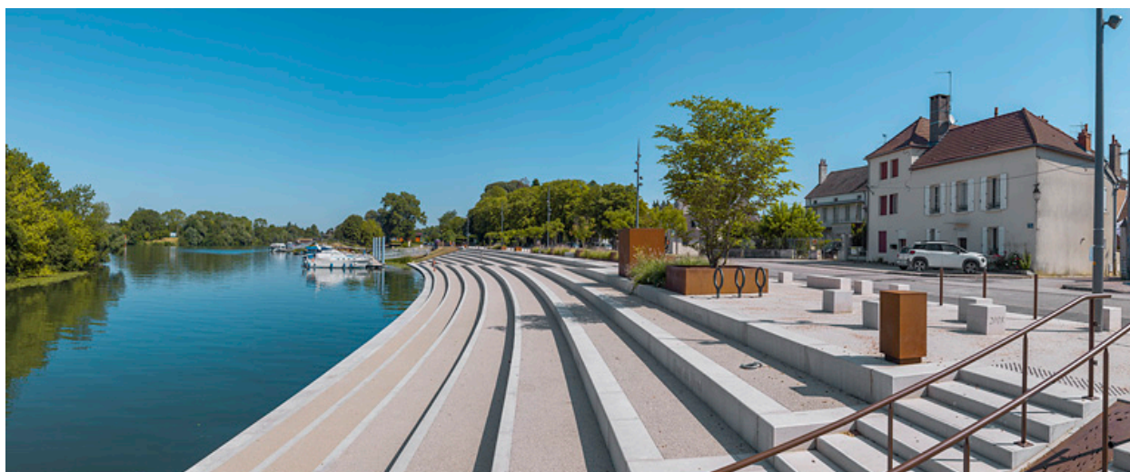
Vue d'ensemble des quais après leur réaménagement.
