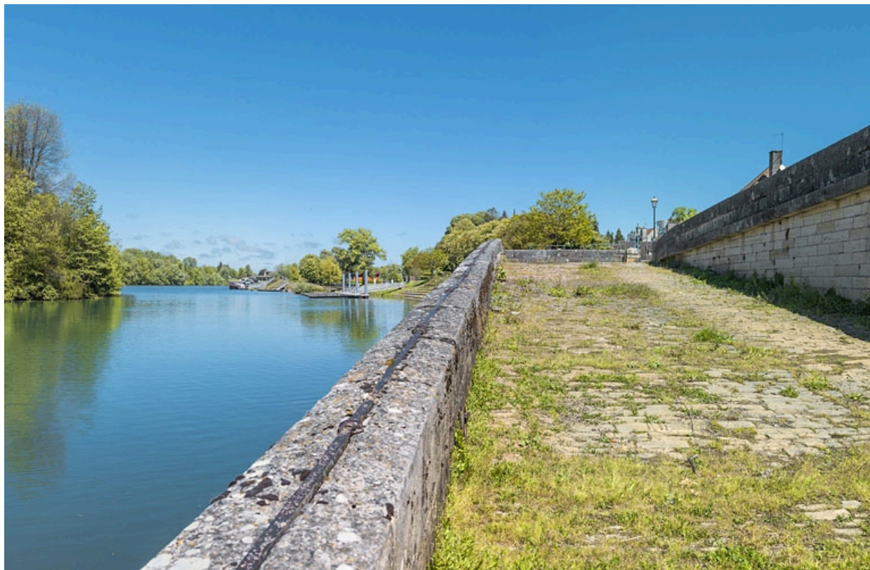
Rampe d'accès située juste en aval des quais à gradins.
