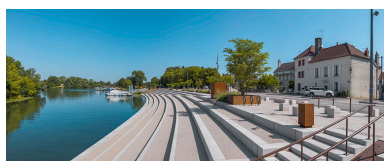
Vue d'ensemble des quais après leur réaménagement. Phot. Thierry Kuntz IVR26_20192100145NUC4A
