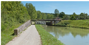
Vue du pont ferroviaire depuis l'aval. Phot. Pierre-Marie Barbe-Richaud IVR26_20112103848NUC4AQ
