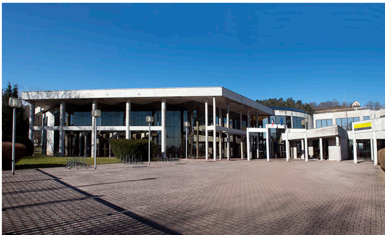
Cour d'accès et entrée depuis l'est.
