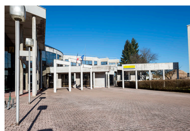
Entrée principale vue du sud-est. Phot. Mary Ruffinoni IVR43_20152500204NUC4A
