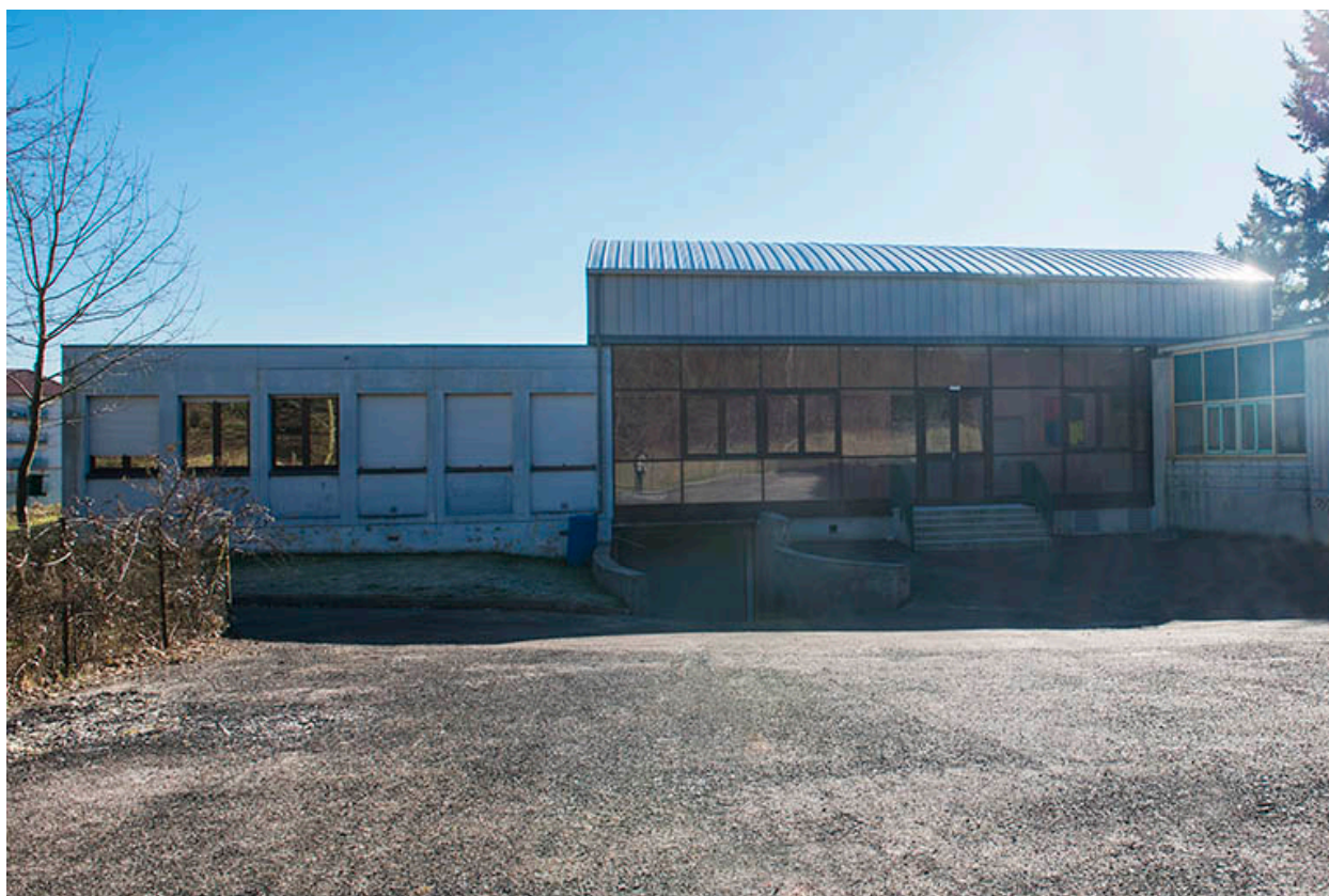
Façade nord-ouest de l'atelier
