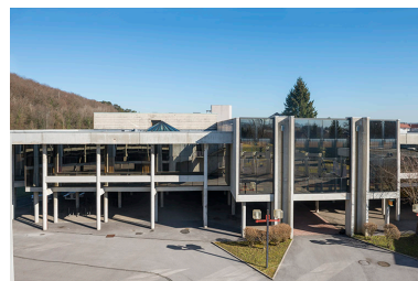
Façade sud du bâtiment d'accueil, préau. Phot. Mary Ruffinoni IVR43_20152500194NUC4A
