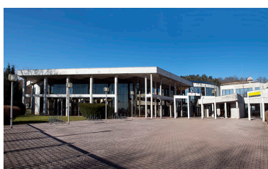
Cour d'accès et entrée depuis l'est. Phot. Mary Ruffinoni IVR43_20152500203NUC4A
