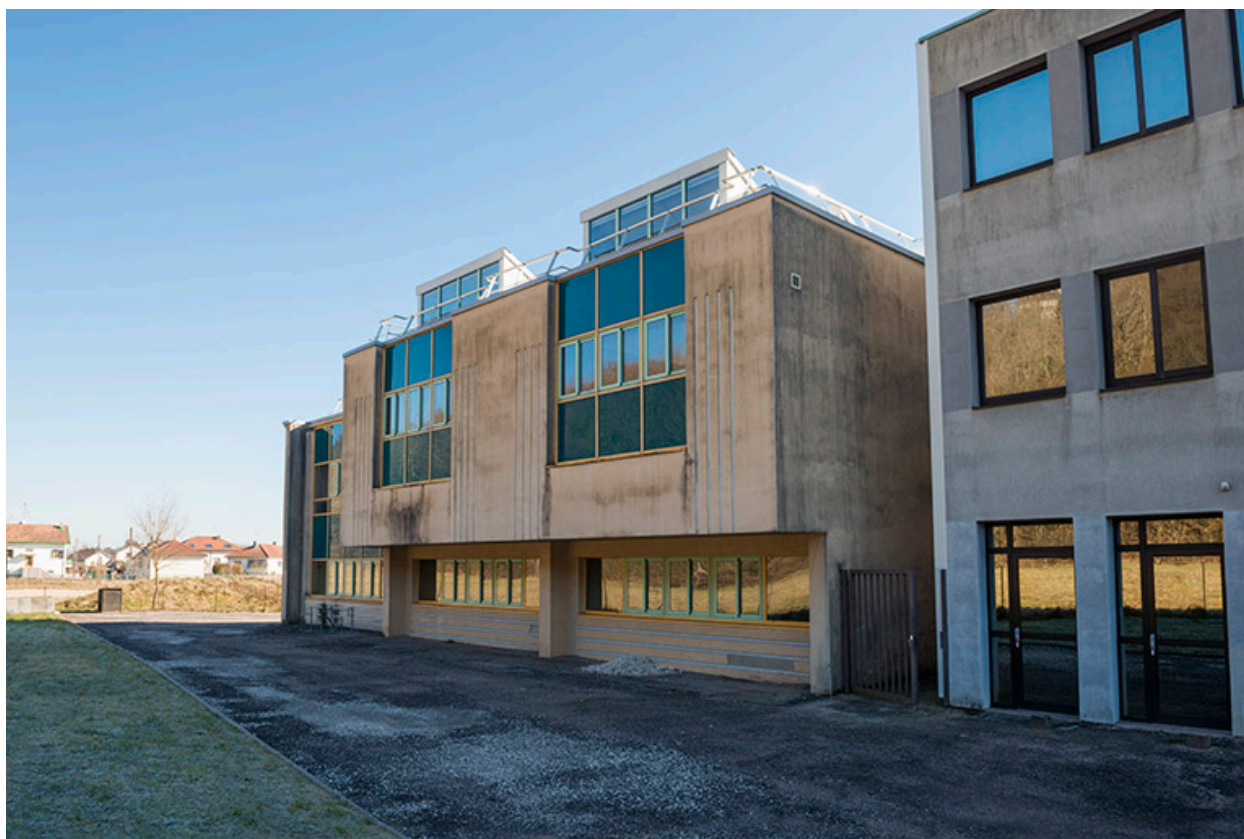
Façade ouest de l'externat nord.
