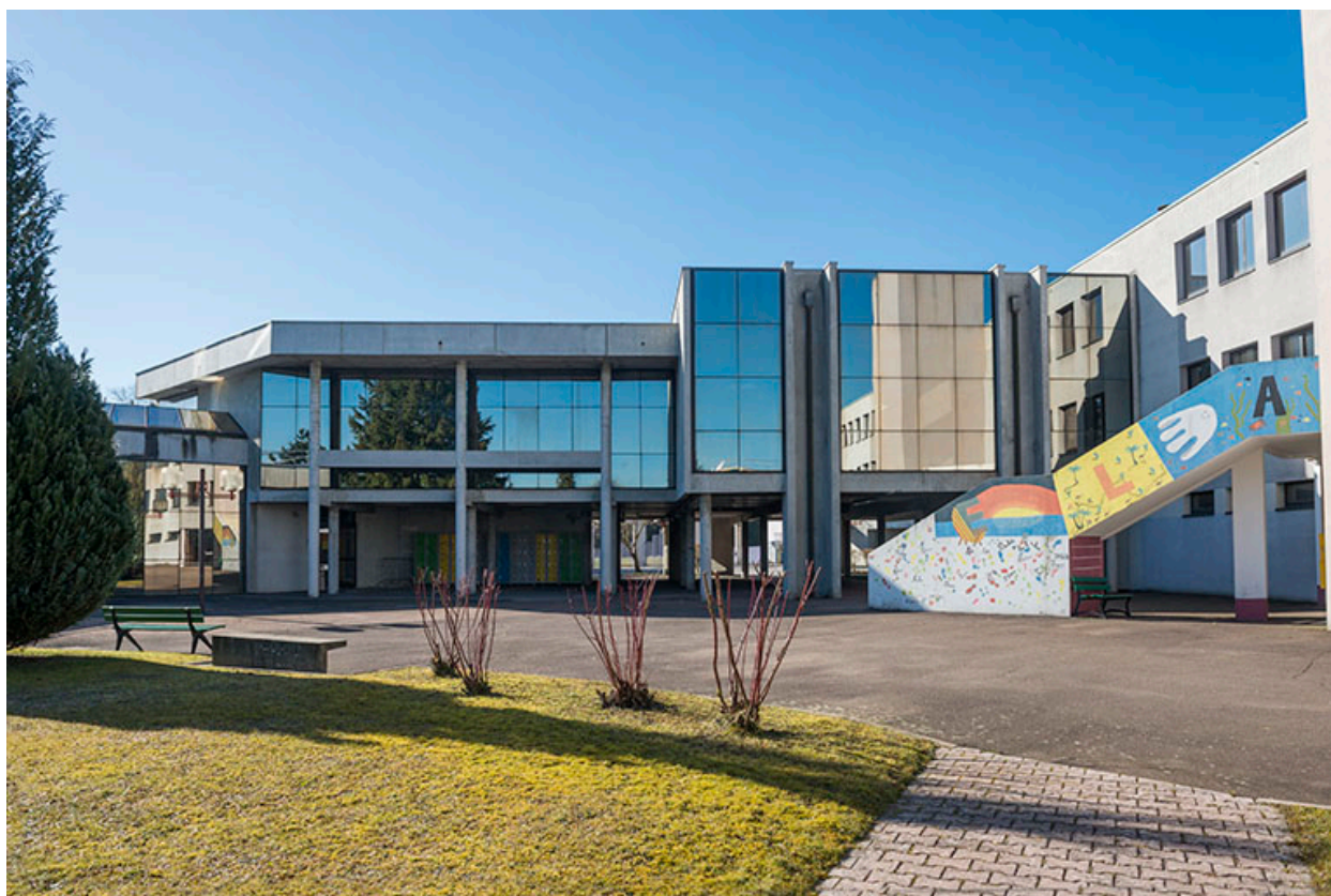
Façade nord du bâtiment d'accueil.
