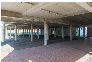
Préau sous le bâtiment d'accueil. Phot. Mary Ruffinoni IVR43_20152500192NUC4A
