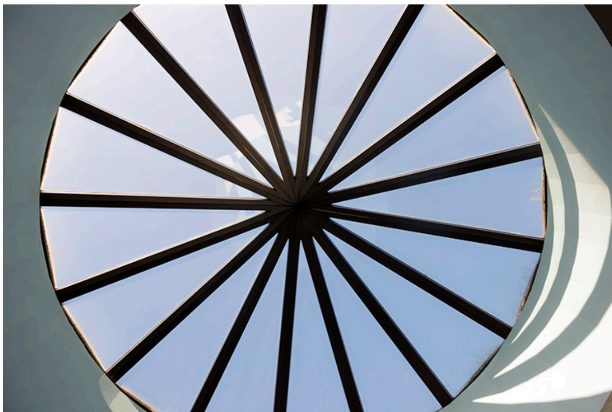
Détail intérieur de l'oculus zénithal du hall.
