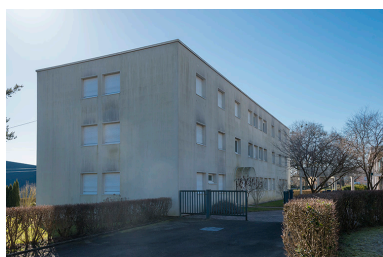
Pignon nord, angle nord- ouest du logement. Phot. Mary Ruffinoni IVR43_20152500199NUC4A
