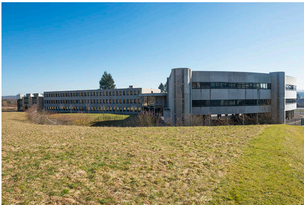
Vue d'ensemble des façades ouest.
