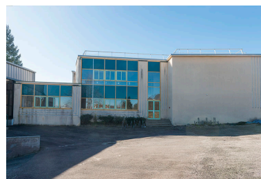
Façade nord de l'externat nord. Phot. Mary Ruffinoni IVR43_20152500202NUC4A
