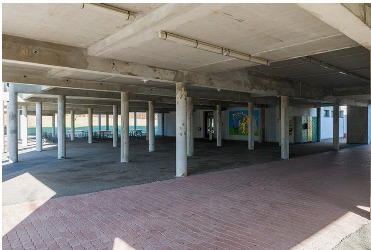
Préau sous le bâtiment d'accueil.
