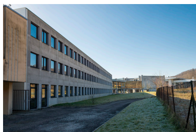
Façade ouest de l'enseignement scientifique. Phot. Mary Ruffinoni IVR43_20152500187NUC4A
