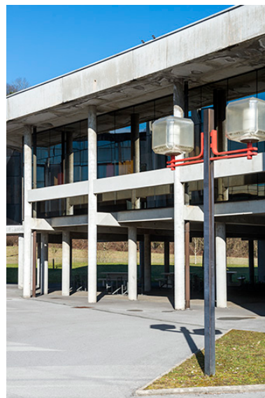
Détail de préau sous le bâtiment d'accueil.
