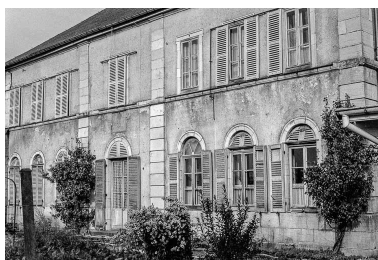
Façade latérale gauche. Phot. Liliane Hamelin IVR43_19752501225Z
