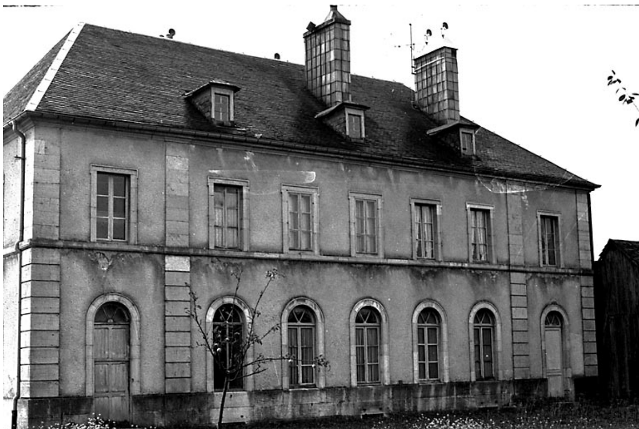
Façade latérale droite.
