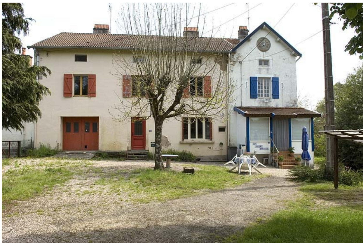
Logement de la centrale hydroélectrique.
