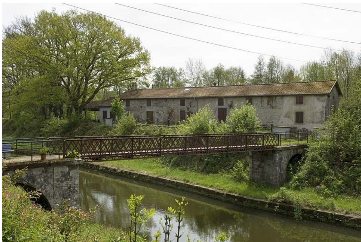
Vue d'ensemble du logement ouvrier collectif (est).
