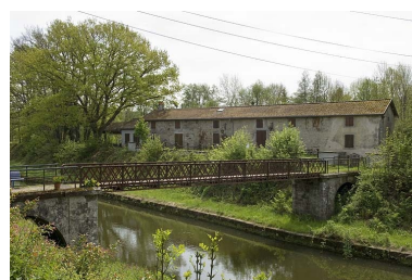
Vue d'ensemble du logement ouvrier collectif (est). Phot. Jérôme Mongreville IVR43_20067000311NUCA
