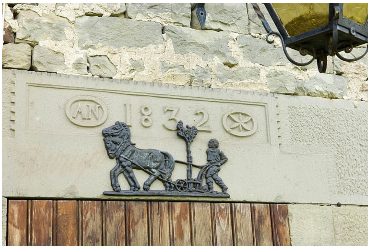
Logement ouvrier collectif (est). Détail d'un linteau.
