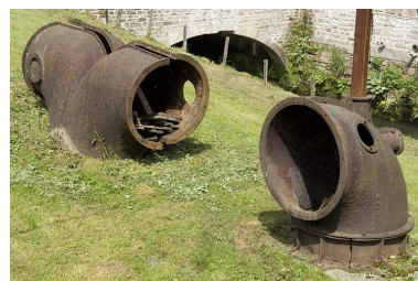
Extrémités de conduites forcées (déposées). Phot. Jérôme Mongreville IVR43_20067000298NUCA
