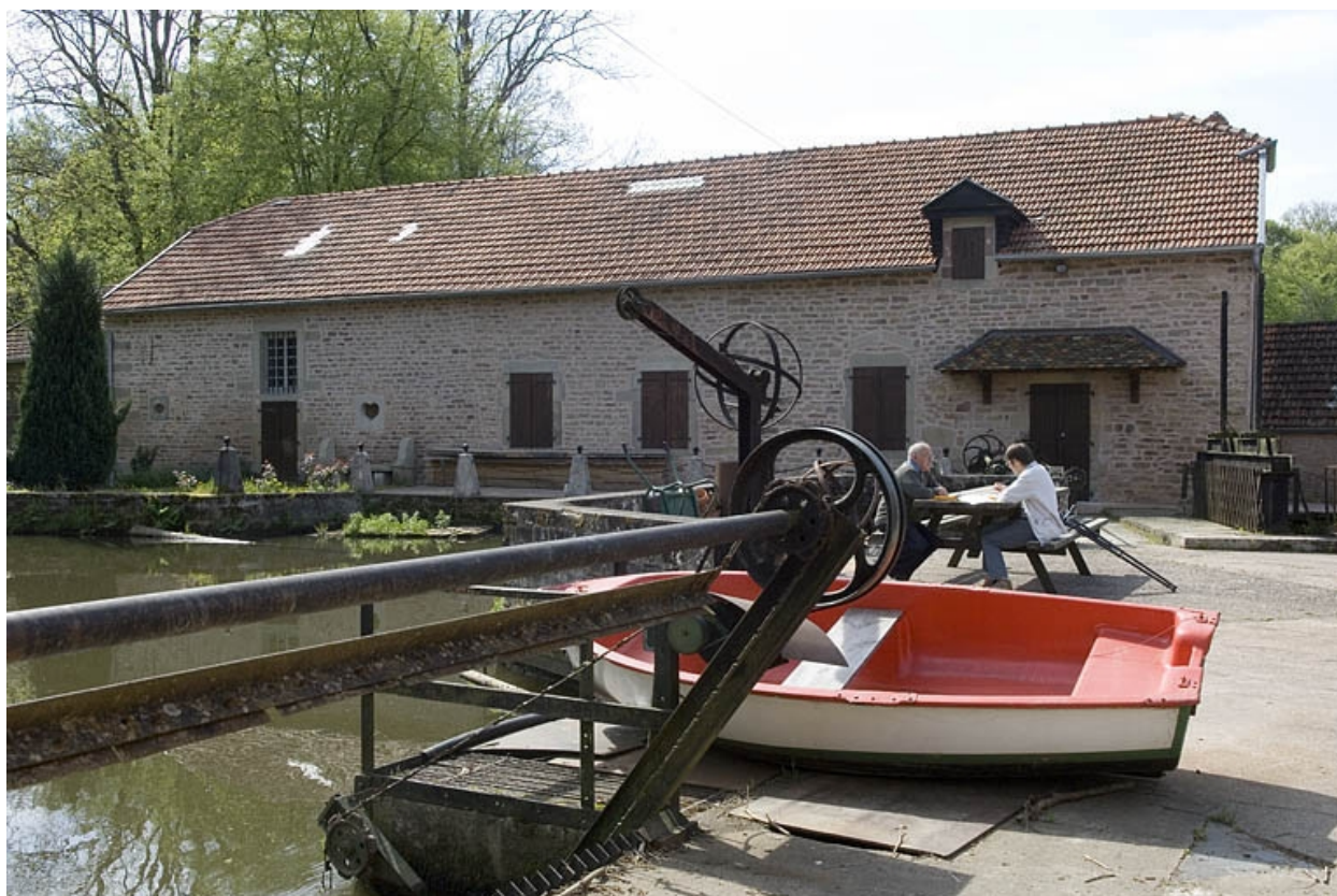
Logement (rive gauche). Façade nord.
