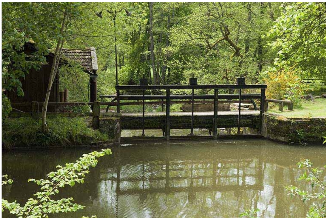
Vannes de décharge sur le bief d'amenée.
