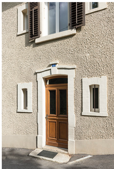
Façade antérieure : entrée.
