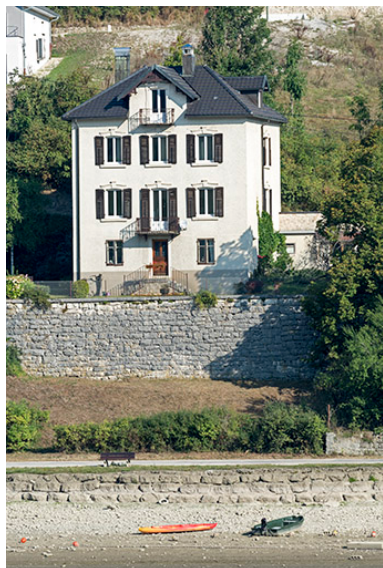
Vue d'ensemble, depuis le sud-est (façade postérieure).
