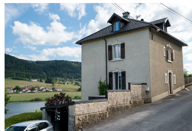
Façades antérieure et latérale gauche.
