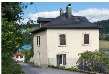
Façades antérieure et latérale droite.
