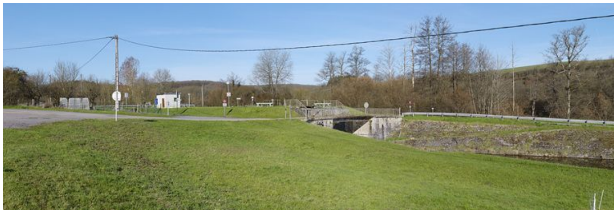
Vue d'ensemble du site d'écluse.
