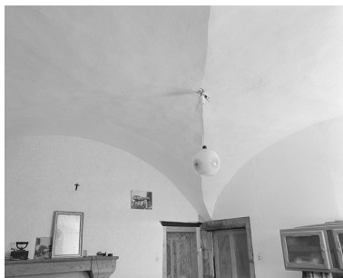
Pièce du rez-de- chaussée, voûte d'arêtes. Phot. Jérôme Mongreville IVR43_19963901159X
