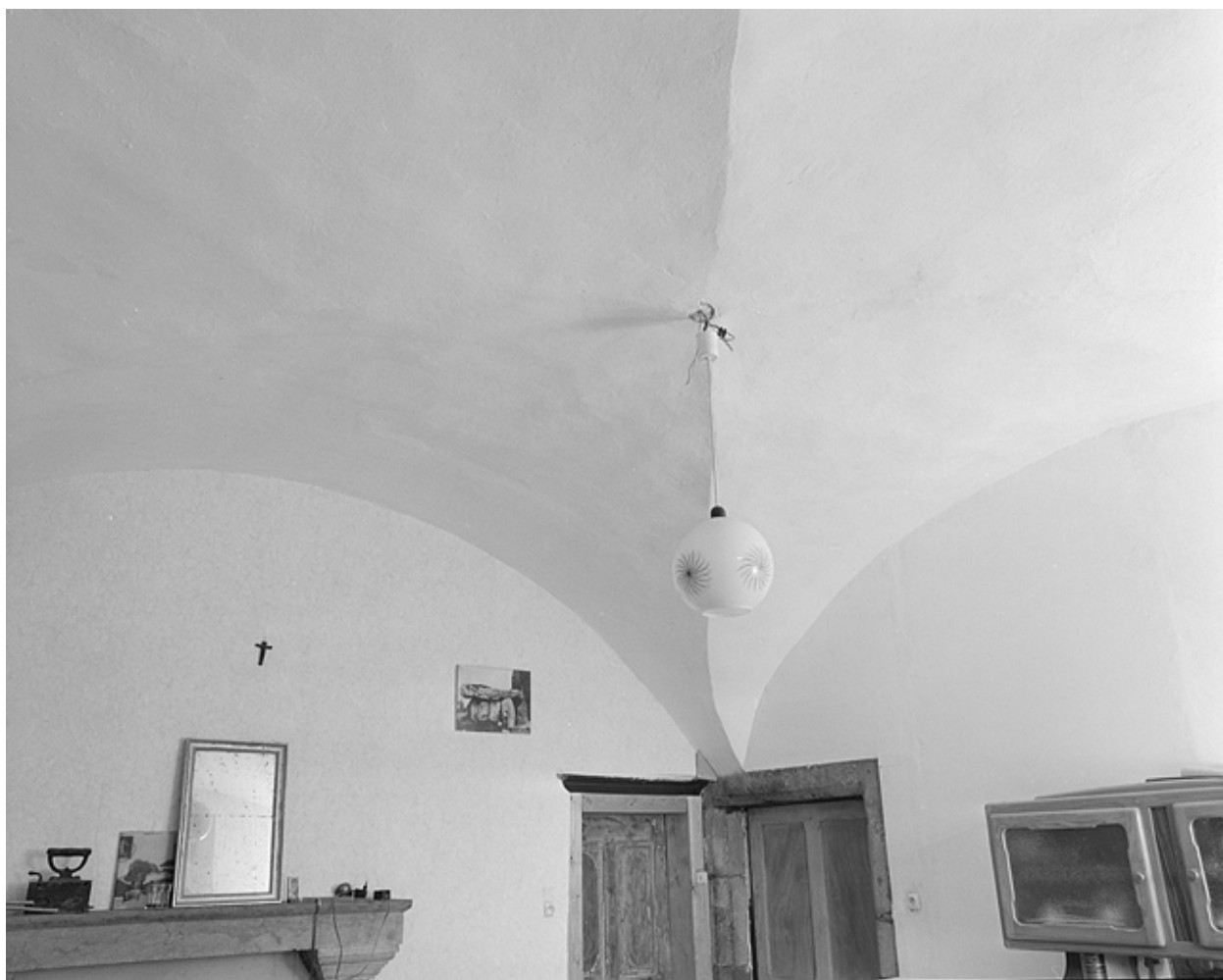
Pièce du rez-de-chaussée, voûte d'arêtes.
