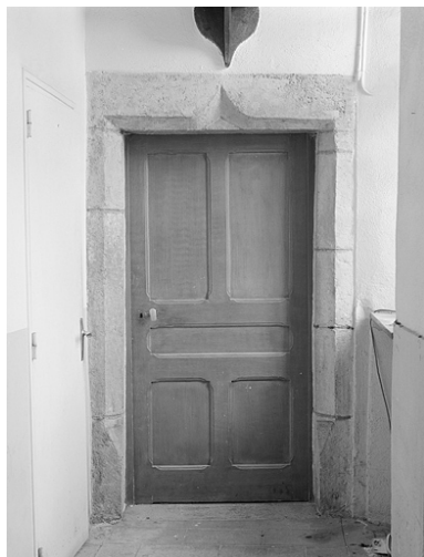
Porte intérieure avec linteau en accolade. Phot. Jérôme Mongreville IVR43_19963901160X
