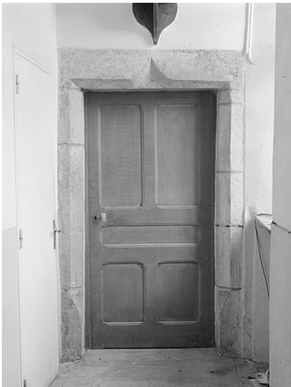
Porte intérieure avec linteau en accolade.
