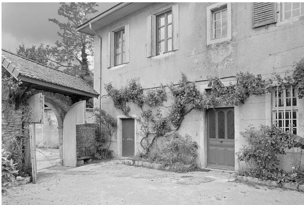
Façade antérieure, partie gauche.
