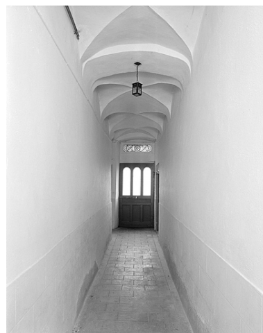
Couloir du rez-de-chaussée. Phot. Jérôme Mongreville IVR43_19963901161X
