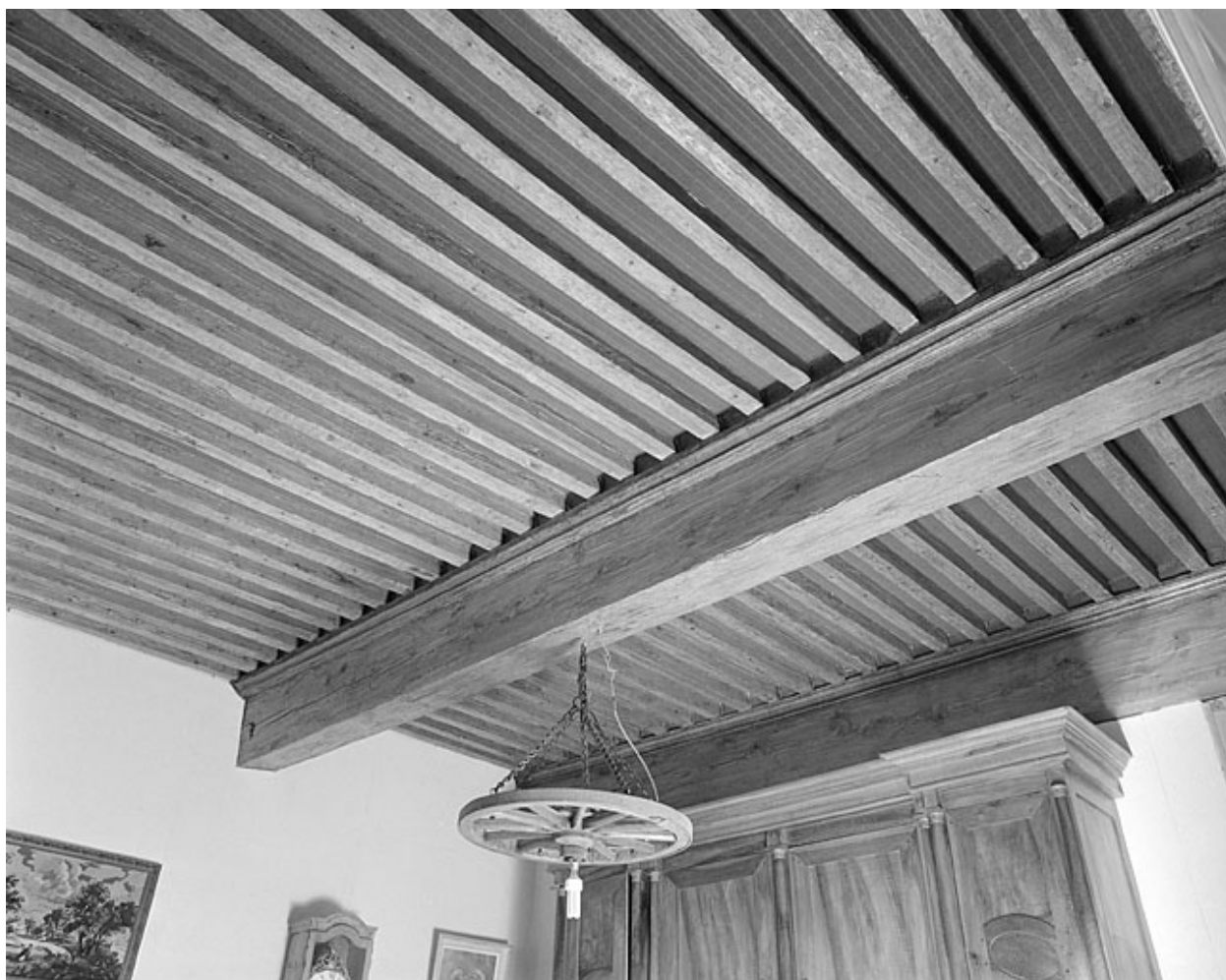
Plafond d'une pièce de l'étage.
