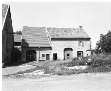
Façade antérieure. Phot. Yves Sancey
