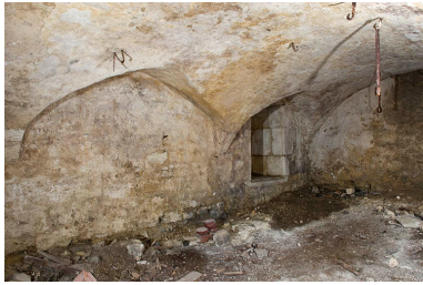
Sous-sol : vue de trois quart gauche. Phot. Jérôme Mongreville IVR43_20092501170NUC2A
