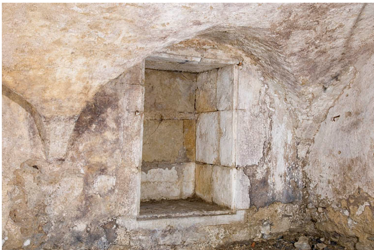
Sous-sol : détail de la niche.
