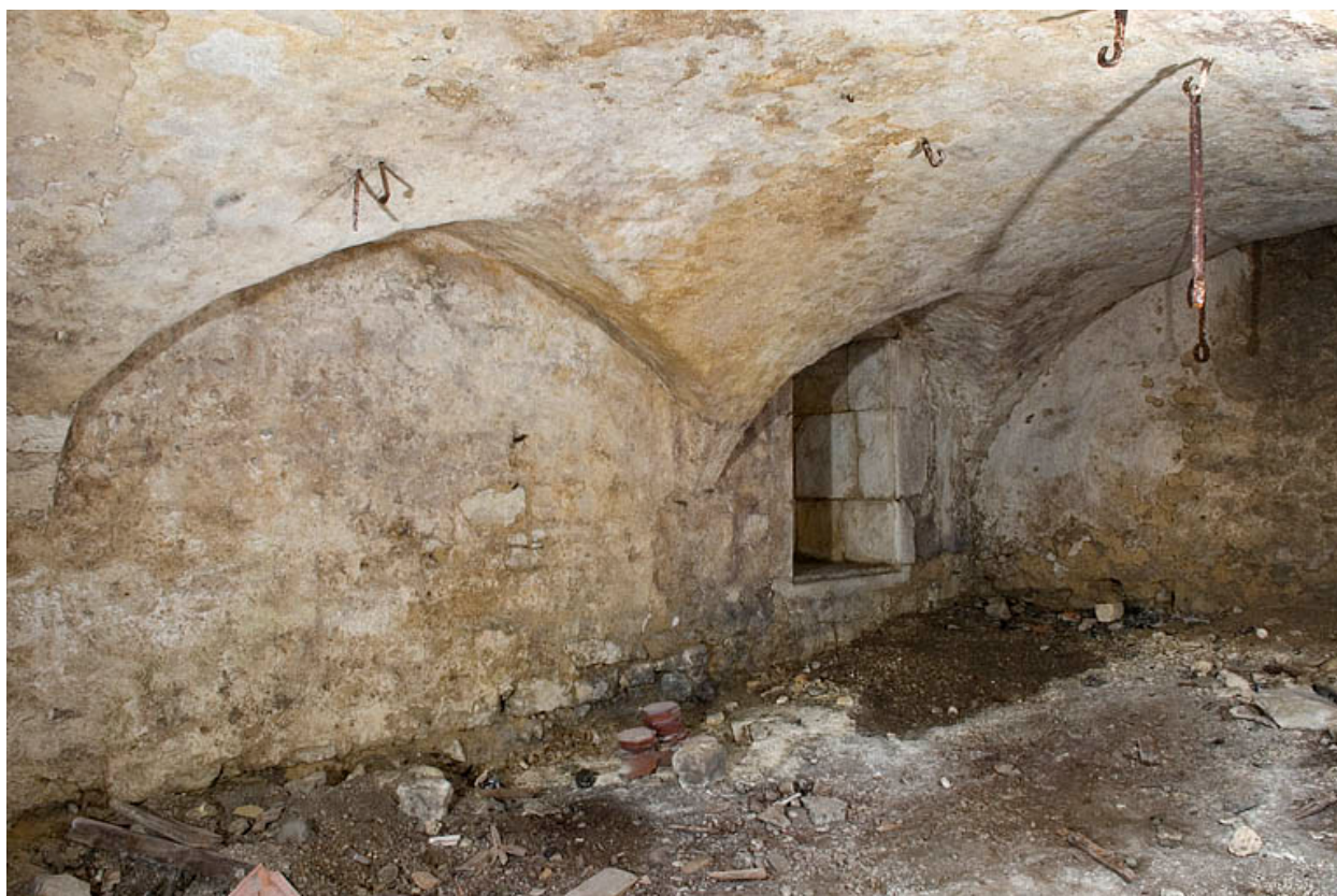
Sous-sol : vue de trois quart gauche.
