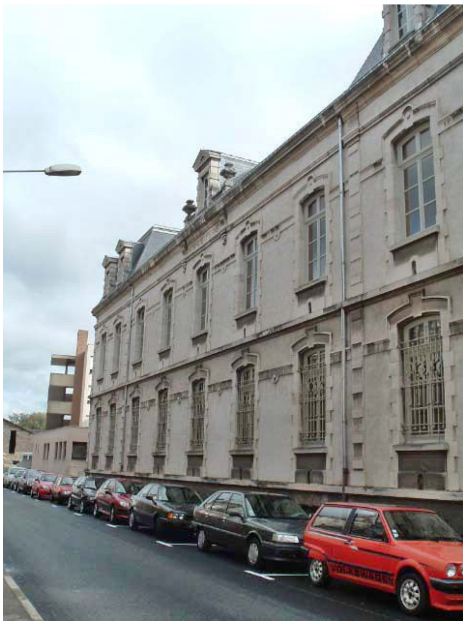
Vue générale latérale de la façade postérieure.
