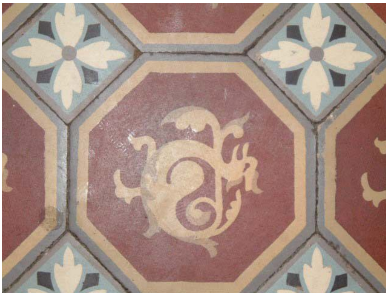
Vue de détail du carrelage du rez-de-chaussée.
