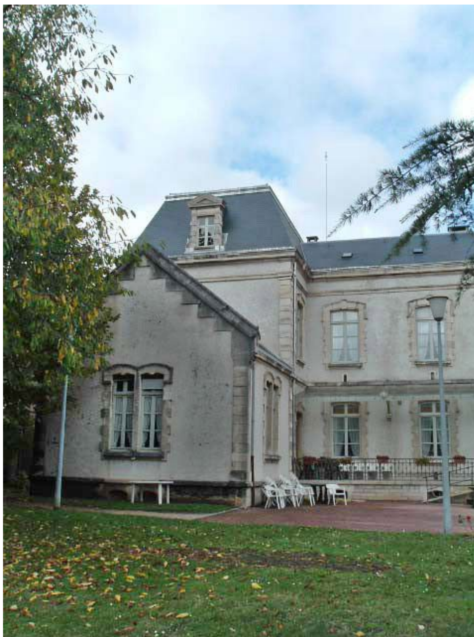
Vue partielle de l'aile gauche.
