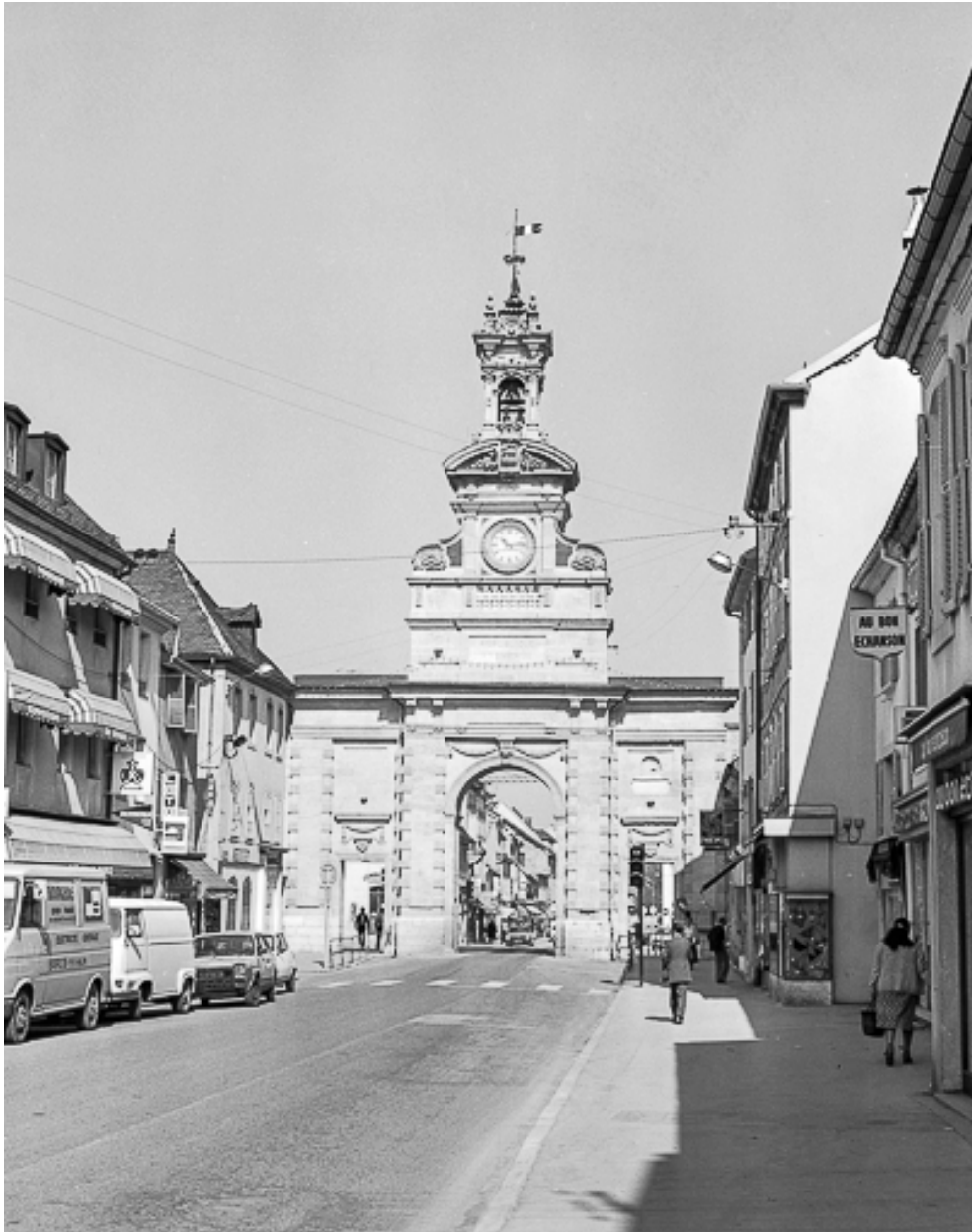
Vue d'ensemble depuis la rue de la République.
