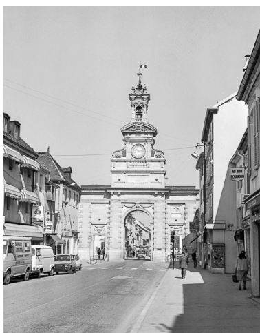
Vue d'ensemble depuis la rue de la République. Phot. Yves Sancey IVR43_19802500264X
