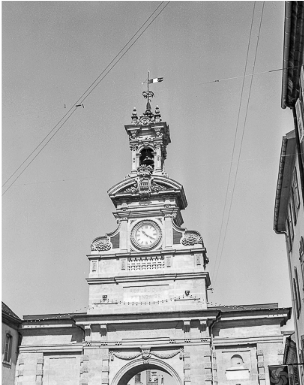
Vue de la partie supérieure et de l'arcade centrale depuis la rue de la République.
