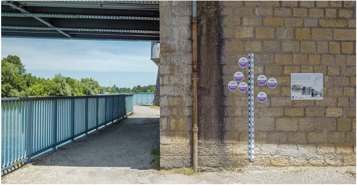
Détail des repères de crues.
