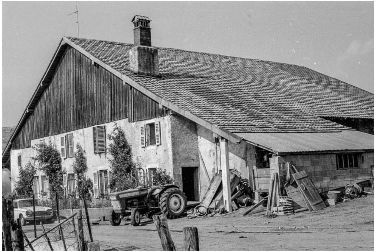
Pignon d'habitation et gouttereau postérieur.
