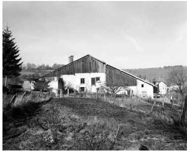
Ferme située rue de la Poste. Phot. Dominique Dominguez IVR43_19802500022X
