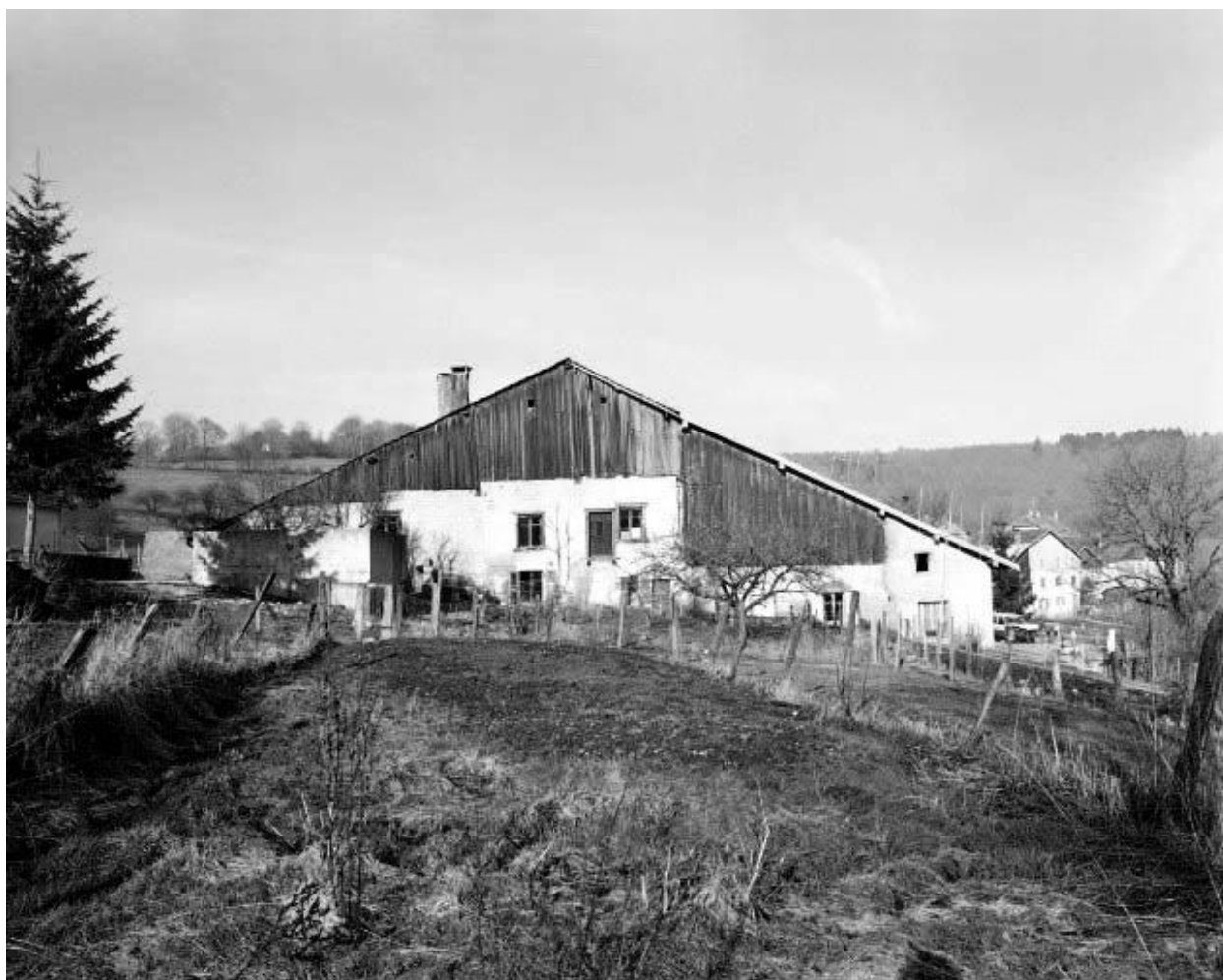
Ferme située rue de la Poste.
