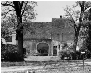
Façade antérieure en 1979. Phot. Bernard Lardière IVR43_19793900353X
