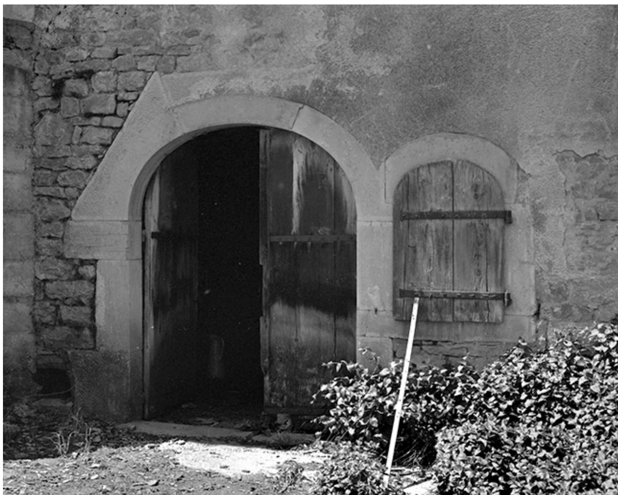
Détail : porte et fenêtre de l'étable.
