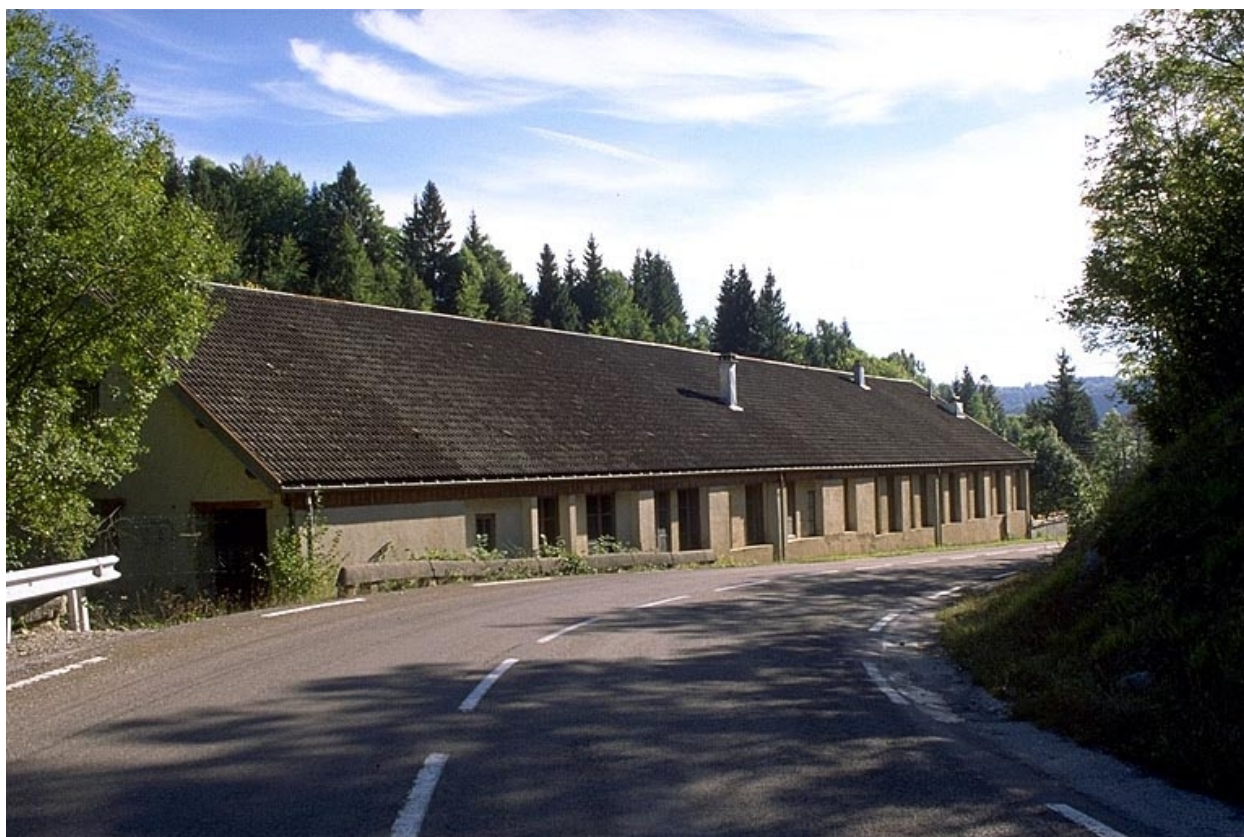
Façade ouest de l'atelier de fabrication.
