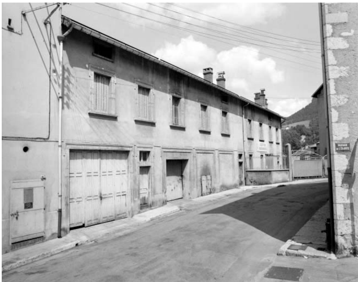
Transformateur, entrepôt industriel et bureau.
