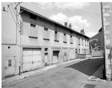
Transformateur, entrepôt industriel et bureau. Phot. Jérôme Mongreville IVR43_19923900666X
