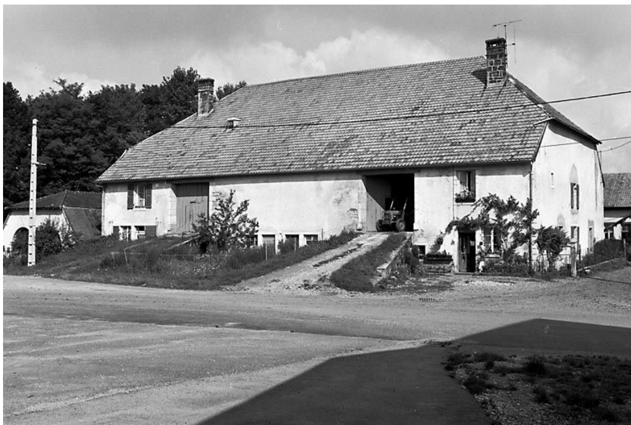
Ferme située rue du Château.
