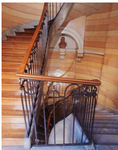
Escalier d'honneur : vue d'ensemble depuis le premier palier. Phot. Yves Sancey IVR43_20012500320XA
