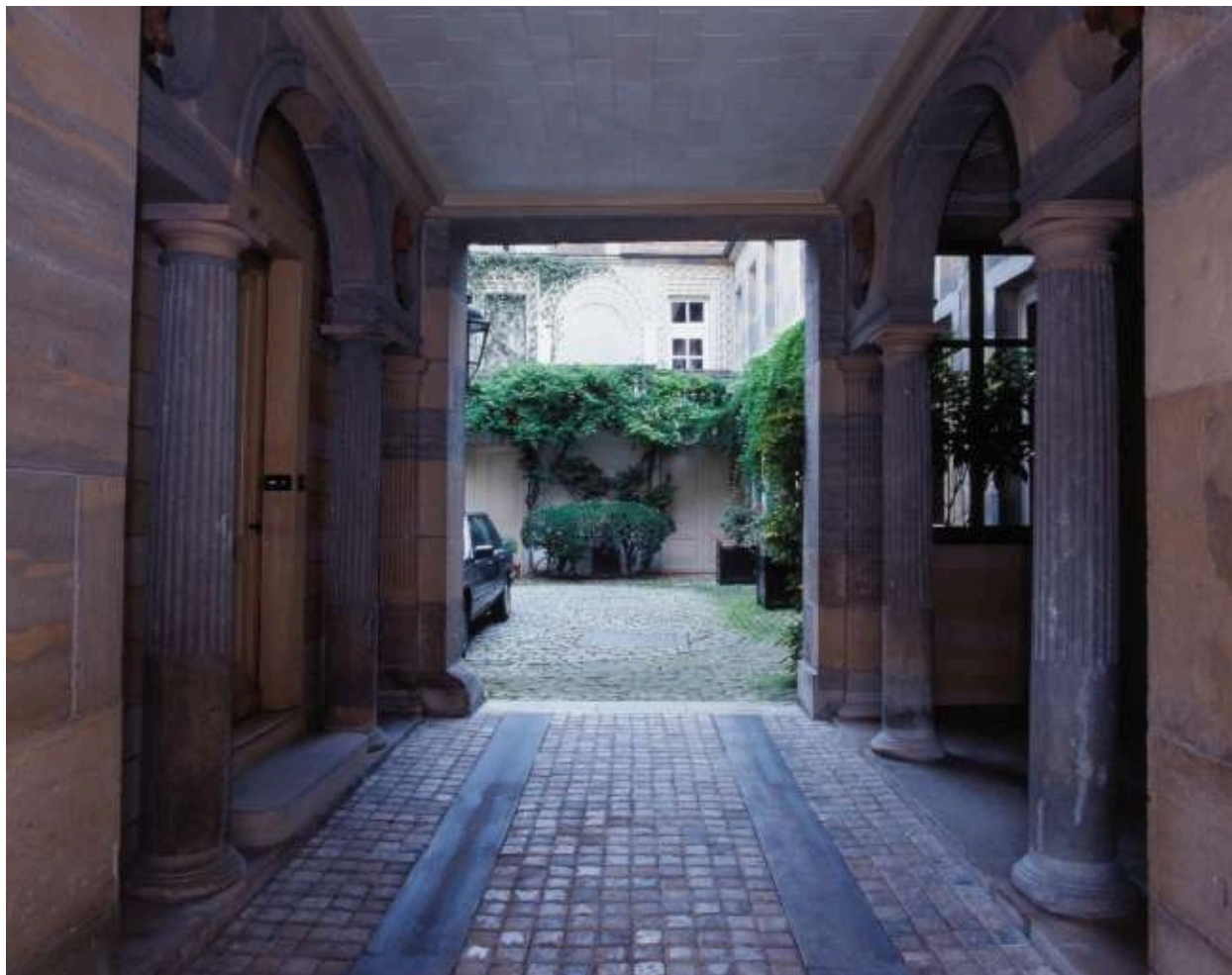
Vue d'ensemble du passage d'entrée depuis la rue.
