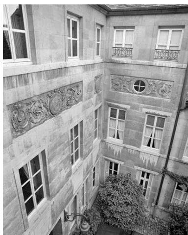
Façade sur cour depuis l'avant-corps gauche. Phot. Yves Sancey IVR43_20012500301X
