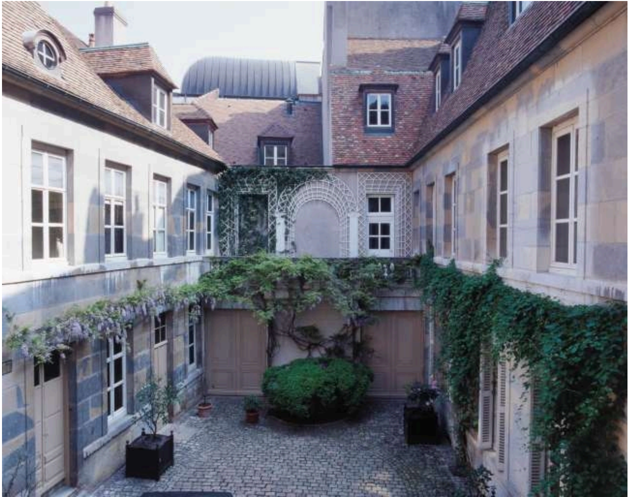
Vue d'ensemble de la cour depuis le logis sur rue.
