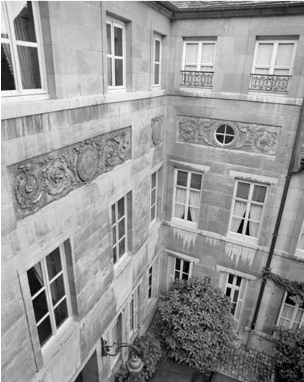
Façade sur cour depuis l'avant-corps gauche.
