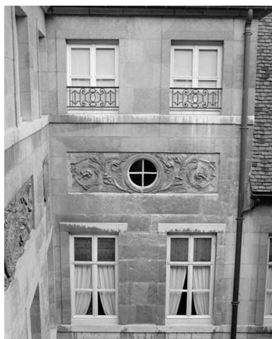
Façade sur cour : détail des décors de l'avant-corps droit. Phot. Yves Sancey IVR43_20012500302X
