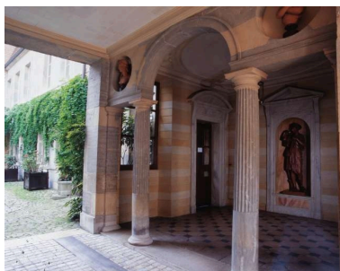
Passage d'entrée : détail de la partie droite. Phot. Yves Sancey IVR43_20012500305XA
