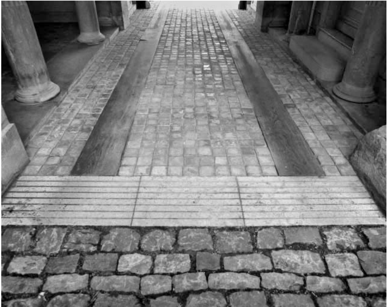
Passage d'entrée : détail du revêtement.
