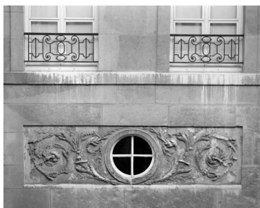
Façade sur cour : détail des décors de l'avant-corps droit. Phot. Yves Sancey IVR43_20012500303X
