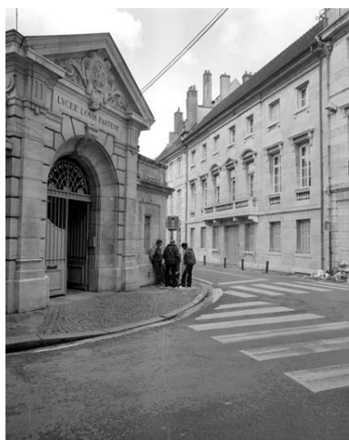
Vue d'ensemble de la façade sur rue, de trois quarts droit. Phot. Yves Sancey IVR43_20012500285X
