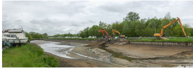
Bief vide au niveau de la halte fluviale de Bois-Bretoux, pendant les travaux de réfection de la chaussée. Phot. Pierre-Marie Barbe-Richaud IVR26_20137100382NUC2AQ
