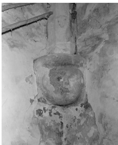
Chœur, culot postérieur droit. Phot. Jean-Luc Duthu IVR26_19732100274X
