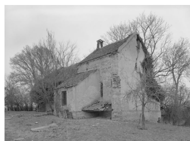
Elévation droite et chevet. Phot. Michel Thierry IVR26_19732100266V
