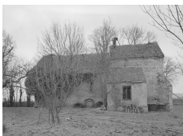
Elévation droite. Phot. Michel Thierry IVR26_19732100267V
