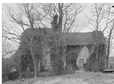
Elévation gauche. Phot. Michel Thierry IVR26_19732100264V
