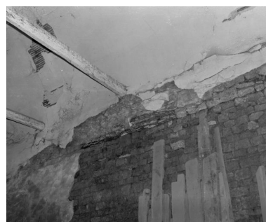
Mur gauche de la nef, détail. Phot. Jean-Luc Duthu IVR26_19732100275X
