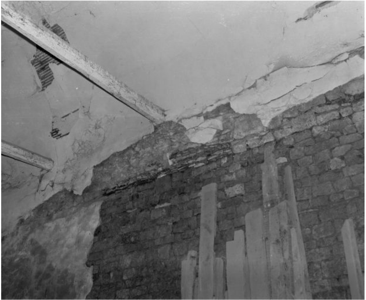
Mur gauche de la nef, détail.
