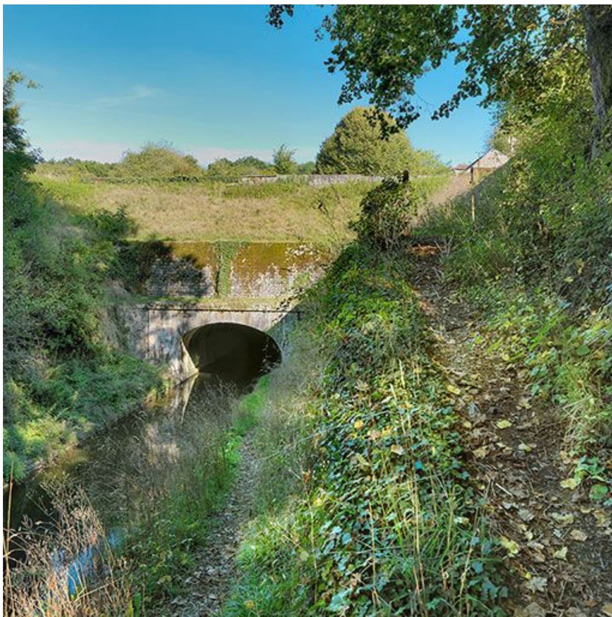
Entrée du tunnel de La Collancelle.
