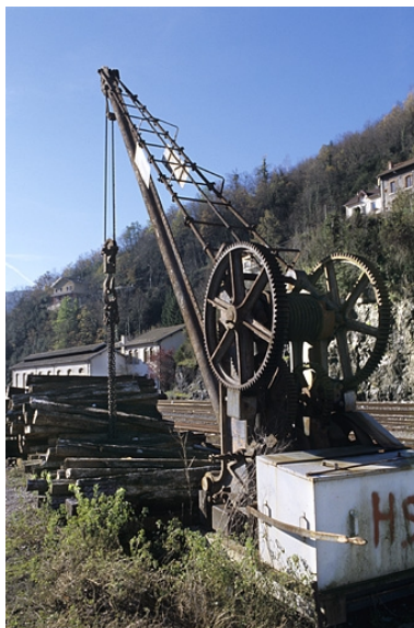
Vue d'ensemble, côté moteur. Phot. Yves Sancey IVR43_20043900440ZA
