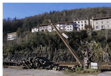
Vue d'ensemble, depuis l'est. Phot. Yves Sancey IVR43_20043900439ZA
