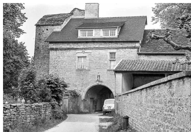
Porte de l'abbaye, face interne. Phot. Guy Forestier IVR43_19743900735Z
