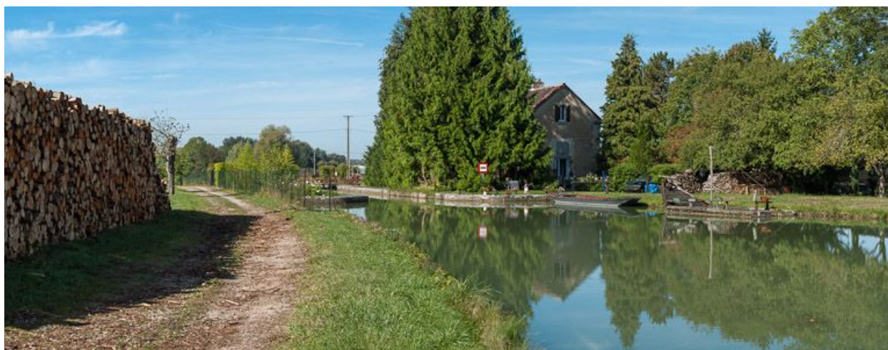
Vue d'ensemble prise d'amont.
