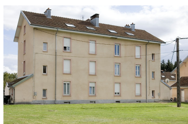
Logement ouvrier collectif. Phot. Jérôme Mongreville
