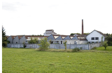
Vue rapprochée depuis le nord. Phot. Jérôme Mongreville IVR43_20077000532NUCA
