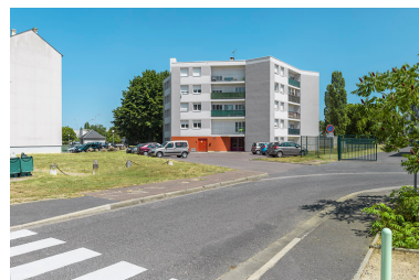
Bâtiment X, façades sud-ouest. Phot. Thierry Kuntz IVR26_20155800078NUC4A
