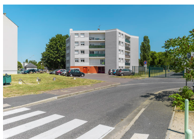
Bâtiment X, façades sud-ouest. Phot. Thierry Kuntz IVR26_20155800076NUC4A
