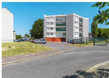
Bâtiment X, façades sud-ouest. Phot. Thierry Kuntz IVR26_20155800077NUC4A
