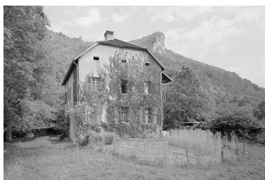
Façade postérieure. Phot. Jérôme Mongreville IVR43_19973900839V
