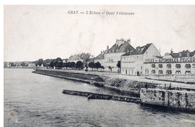
Gray - L'écluse et quai Villeneuve, carte postale. Phot. Jérôme Mongreville, Autr. auteur inconnu IVR43_20197000442NUC4A
