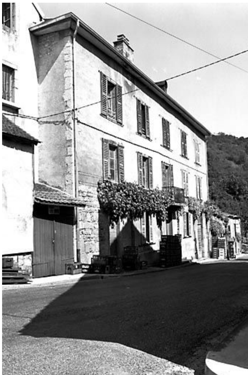
Façade antérieure et face latérale droite.
