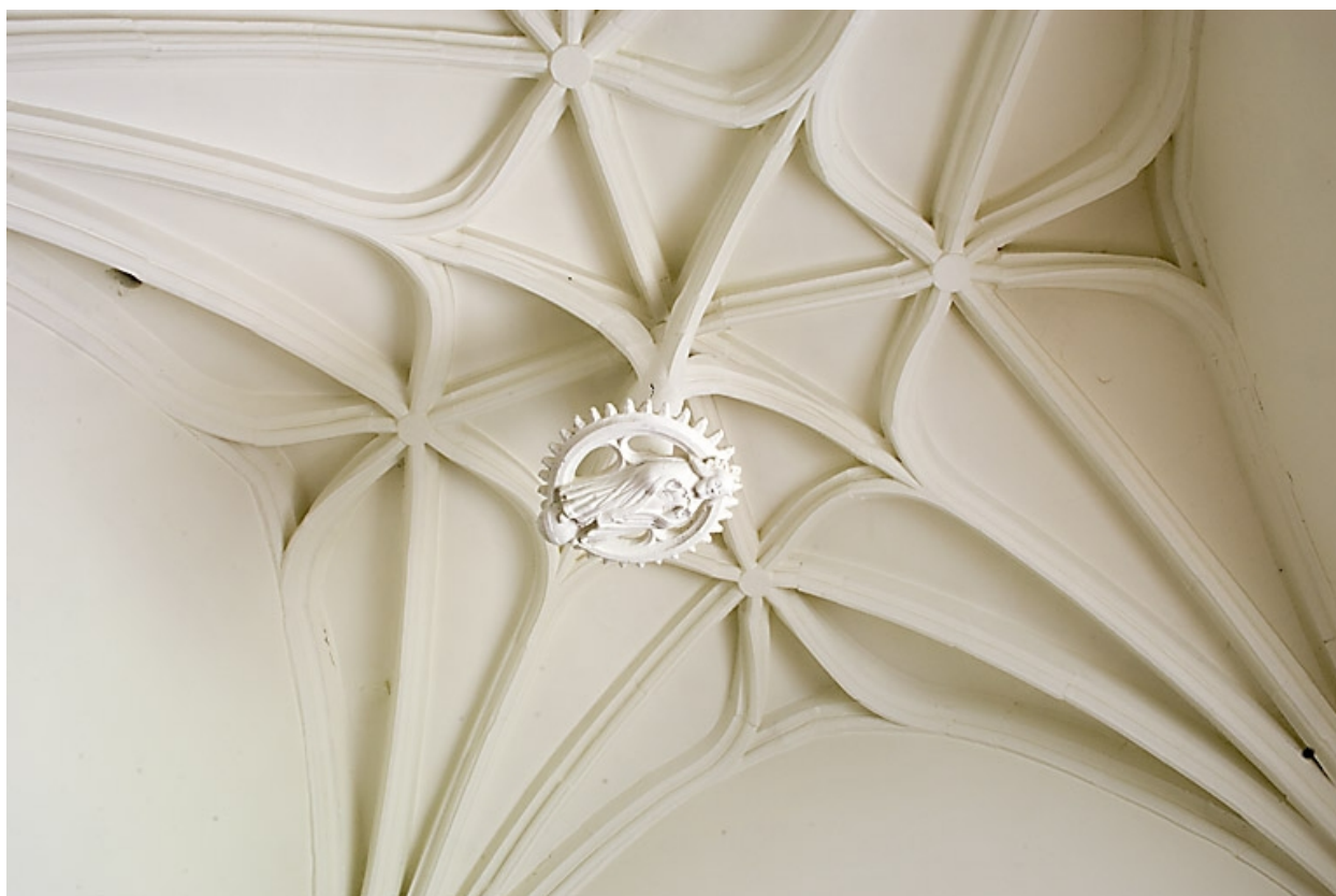
Voûte de la sacristie.
