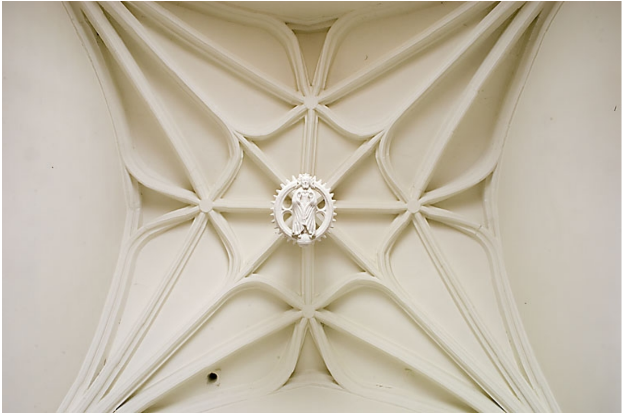
Voûte de la sacristie.
