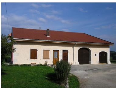
Vue latérale de la façade antérieure.
