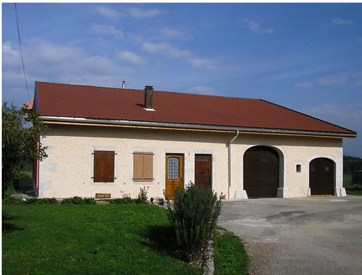
Vue latérale de la façade antérieure.
