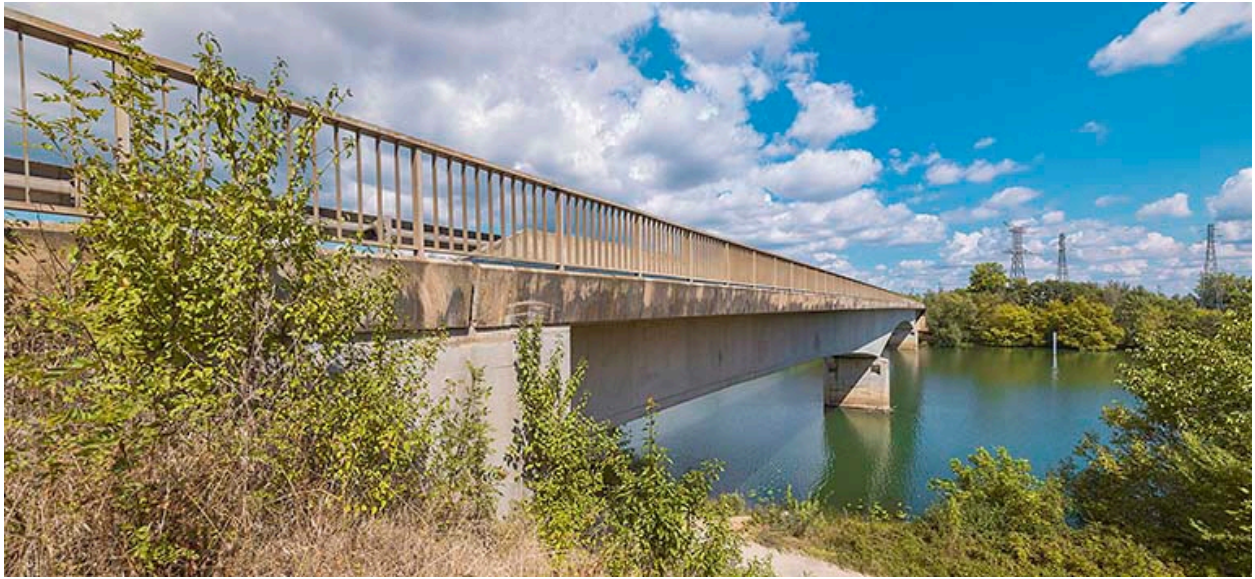
Vue d'ensemble du pont, depuis la rive droite.
