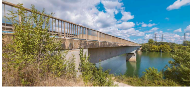
Vue d'ensemble du pont, depuis la rive droite. Phot. Thierry Kuntz IVR26_20207100364NUC4A
