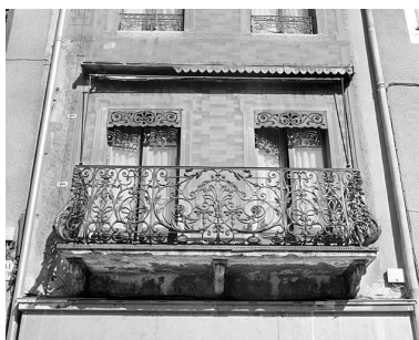
Elévation du premier étage. Phot. Yves Sancey IVR43_20033900546X
