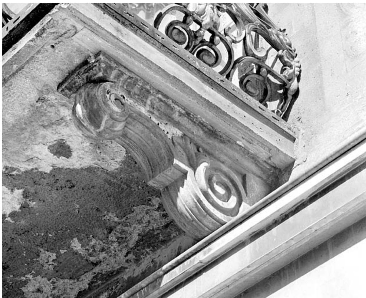
Balcon : détail d'une console.
